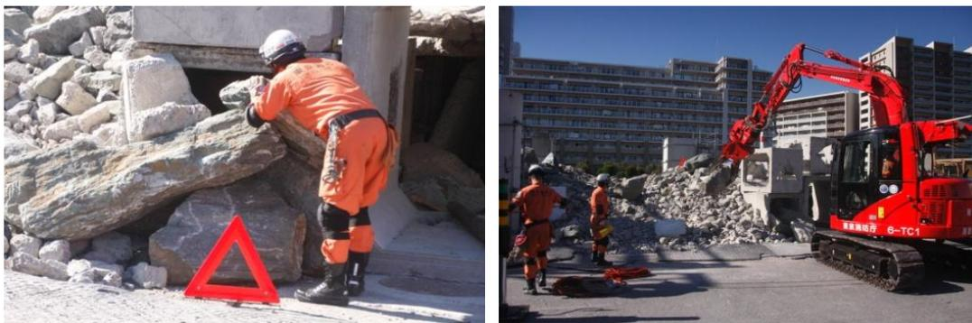
圖 30. 以怪手搭配多功能夾具移除橫坑入口障礙物。
