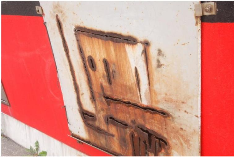
圖 47. 模擬船舶之船體外側架設移動鋼板可進行船殼切割訓練
