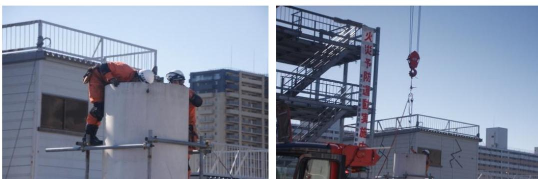
圖 29. 以重型吊車吊鉤做為垂直拖拉固定點。
