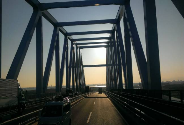
由橋上觀看橋體鋼桁架結構簡單清爽
