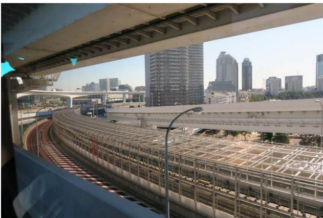
中央軌道系統設置防護遮蔽
