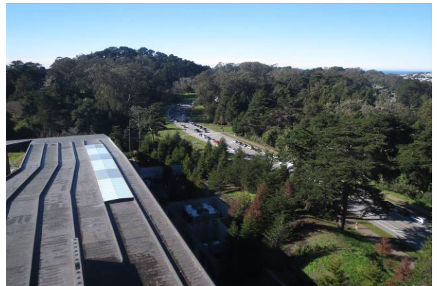
三樓觀景台俯覽美術館屋頂設計及公園內部
