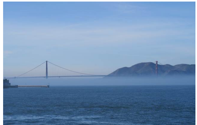
薄霧中金門大橋全景
