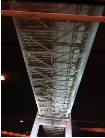
底部桁架結構海灣大橋
