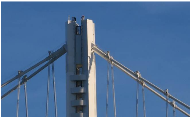
橋塔頂部結構細部
