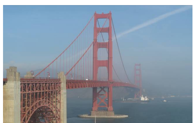
金門大橋橋下淨高約 60 公尺可通行大型船隻
