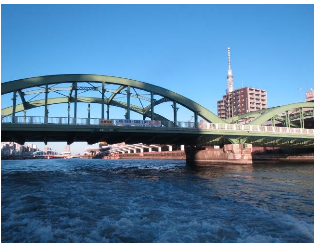
厩橋(橋緣掛著提醒後方橋梁整修公告提示)
