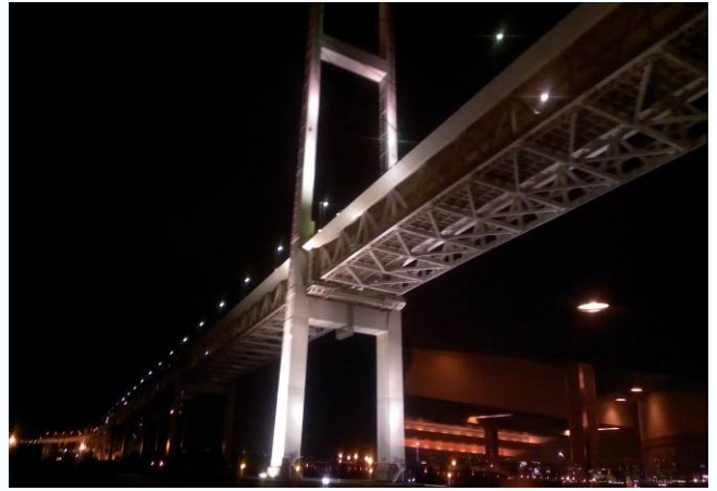
海灣大橋底部結構
