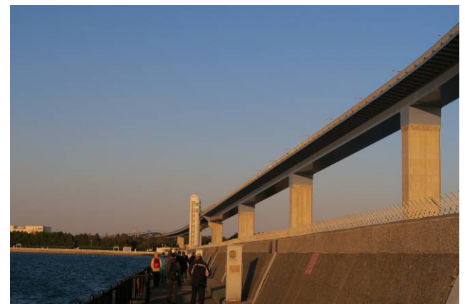
兩側連絡道橋墩旁電梯
