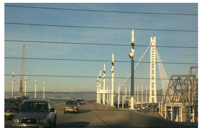
橋面車道(右側為橋面燈柱及橋塔)
