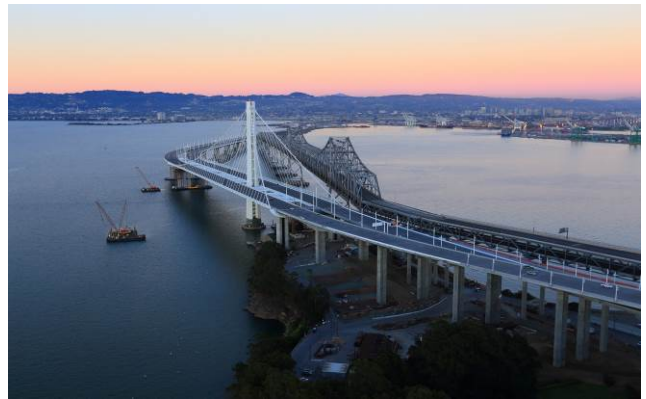
東側新懸索橋與舊桁架橋(拆除中)
