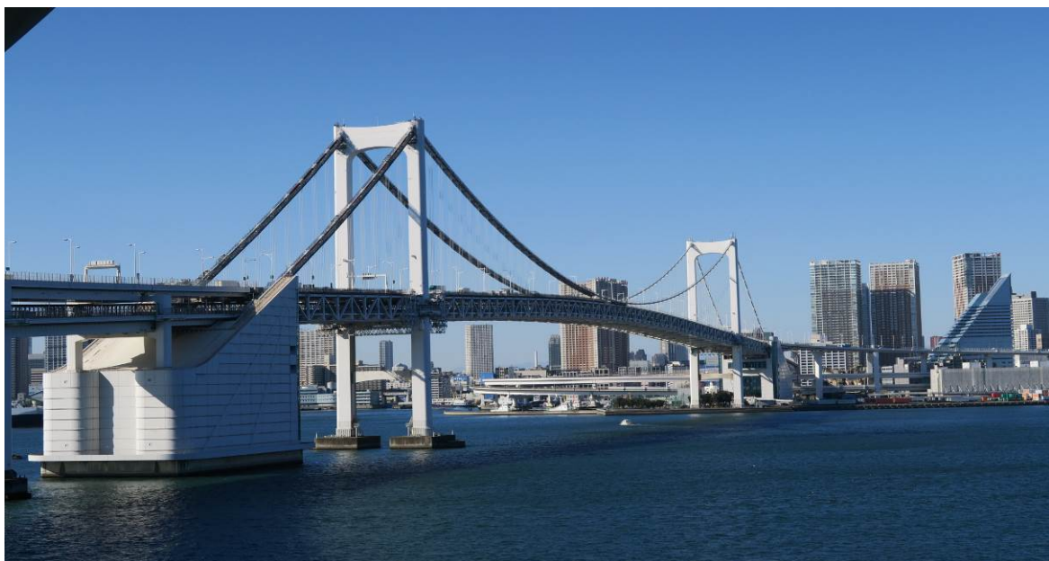
彩虹大橋近影(雙層結構主跨長 570 公尺)
