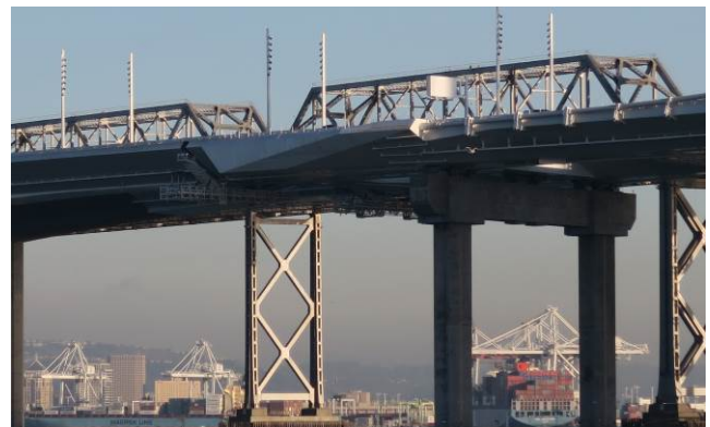
海灣大橋東側錨碇段
