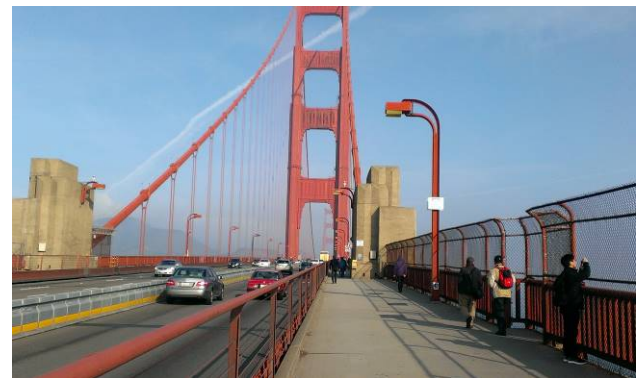
舊金山金門大橋(部分橋段欄杆增設安全網)
