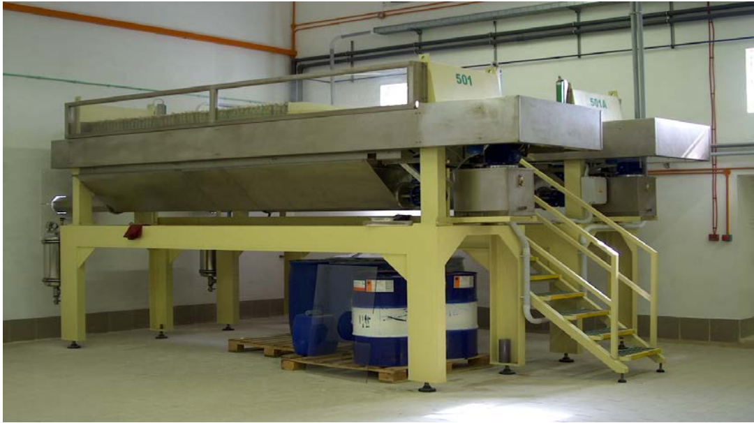
圖十、Aqua Save II 擦拭溶液回收系統板框式壓濾機圖
