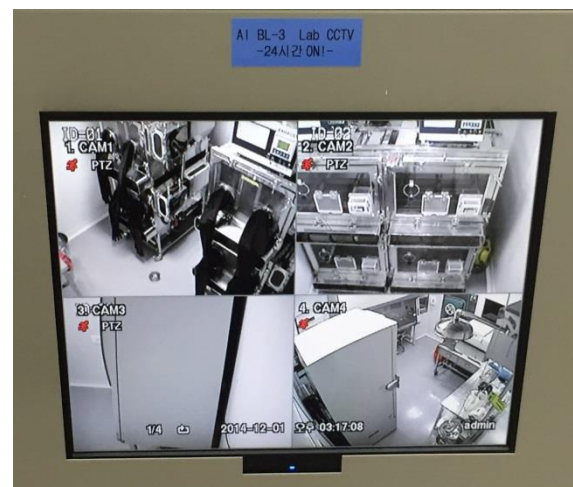
圖三、BSL-3實驗室監控系統
