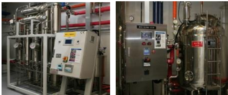
圖十五、純水系統及注射用水系統
