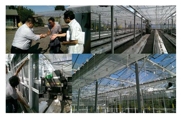
幾天的期間連續下大雪,該農園大約有 20~25 片玻璃屋頂被壓壞。該農園雖然是玻璃溫室,建置成本較高,但業者表示使用年份已經超過 25 年,現場觀察主結構鋼架有經過多次防水漆粉刷所以無銹蝕狀況,溫室目前還是可以正常運作。日本在設施防災之策略上有防風、防雪及防震的考量。防雪的損壞也是其一,就如同該農園,有時甚至造成的損失比風災來得大。該農園菊地弘幸表示,加高之溫室可幫助環境控制的達成,也有助於作物的生長,未來有可能會再將另一個 2.5 公尺高的溫室增高。
