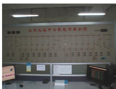
電力系統架構圖及監控設備
