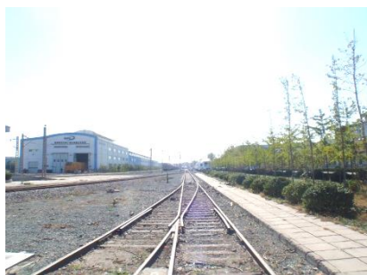
高速動車組及機車車輛整車試驗室
