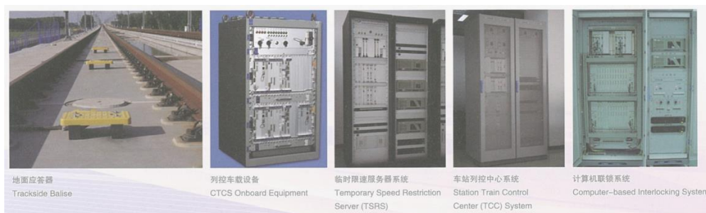
圖 5.1-4 鐵路行車安全保障相關設備
