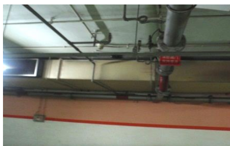
地下停車場車輛偵測器
