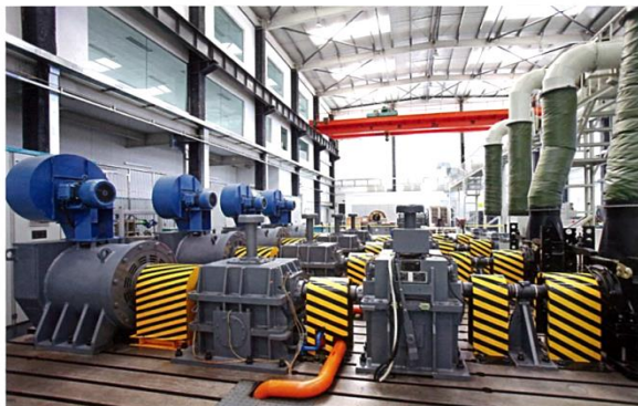
▲ 高速动车组交流传动试验台 High-Speed EMU AC Drive Test Rig
