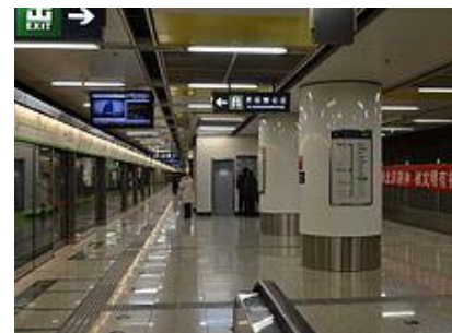
北京西站地鐵站的 9 號線站台與預留軌道的 7 號線同站台換乘
