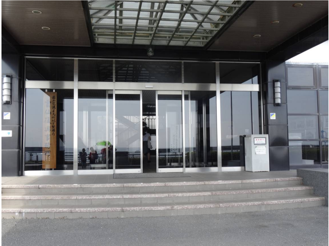
圖 74 國土交通省九州地方整備局雲仙復興事務所正門。
