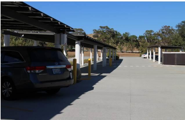
Santa Monica Mountains Recreation Area Visitor Center 聖塔摩尼卡山系遊憩區 遊客中心外停車場，因加州豔 陽高照，停車場加設遮陽
