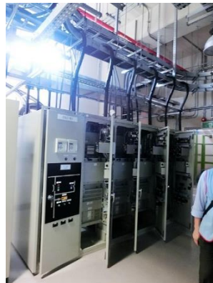
圖3：向上引接的電纜敷設
