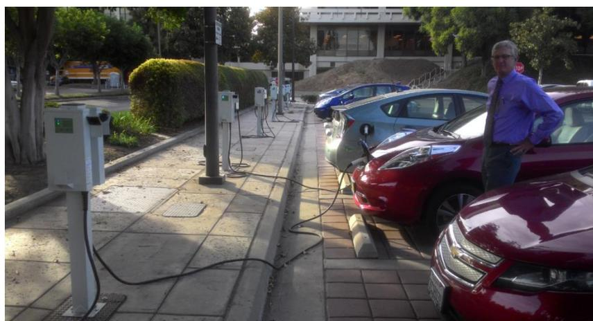
圖 24 SCE 公司總部停車場之電動車充電設備
