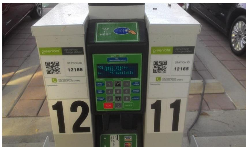
圖 25 SCE 公司總部停車場電動車充電之計量裝置
