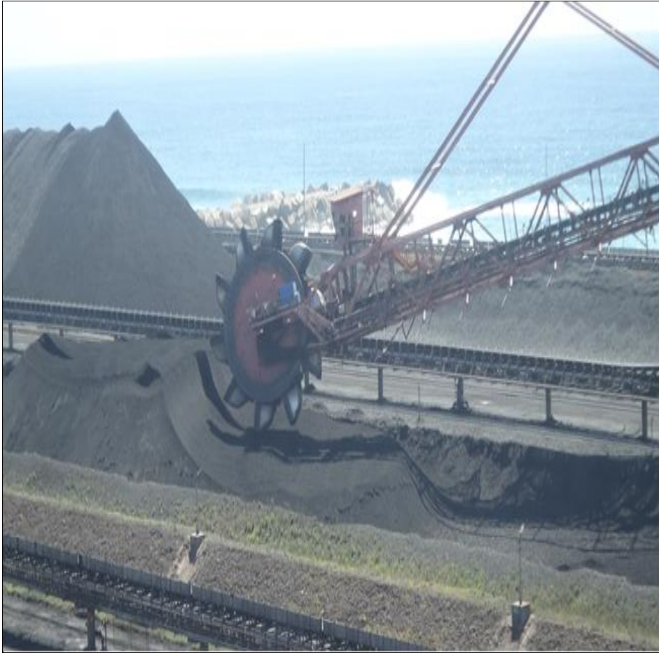
PORT KEMBLA 取 煤 機 (reclaimer)
