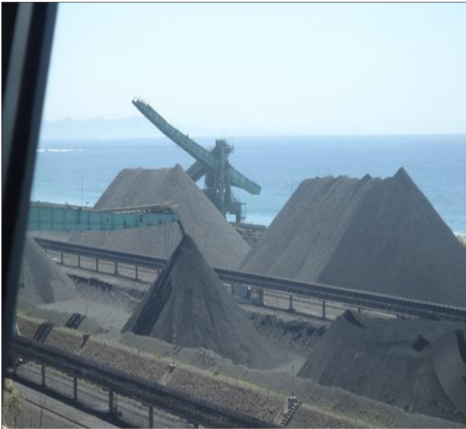
PORT KEMBLA 堆煤機 (stacker)
