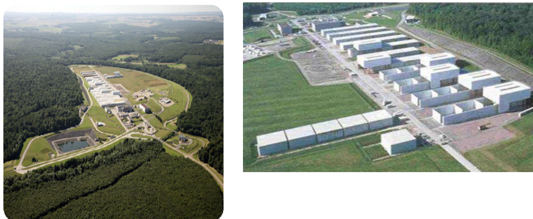
圖 25 中/低處置窖、移動屋頂負壓窖和雨水收集池
