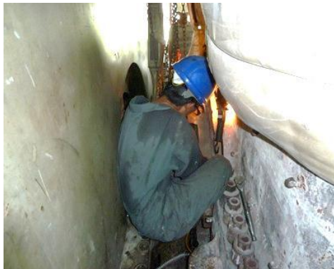
#2 軸承上半吊出
