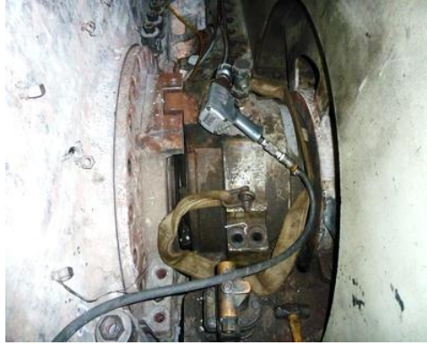
#2 軸承環(外蓋)吊出
