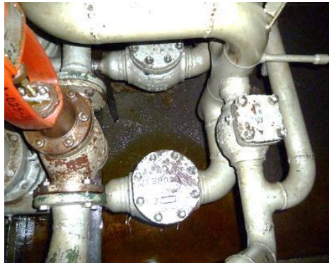
各潤滑油泵 CHECK V/V 檢查
