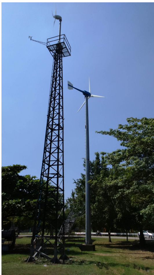
圖 2-11、RMUTT 校區內 5 kW 小型風力機
