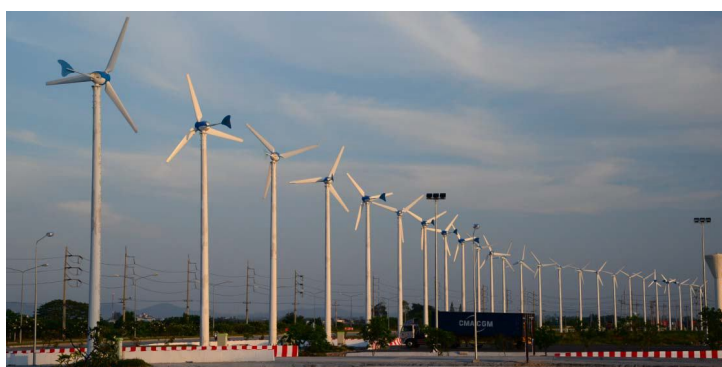
圖 2-3、Prapai 研究中心設置之 7 部 7 kW 小型風力機
