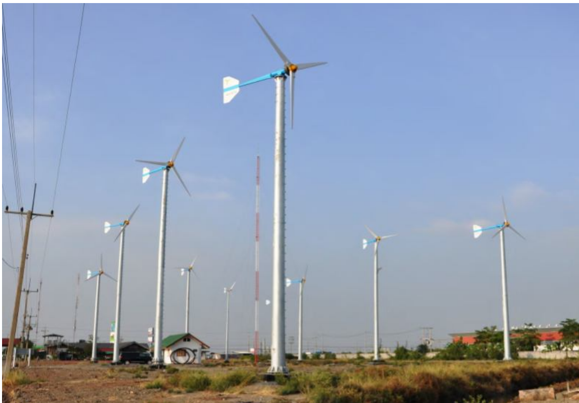
圖 2-3、Prapai 研究中心設置之 7 部 7 kW 小型風力機
