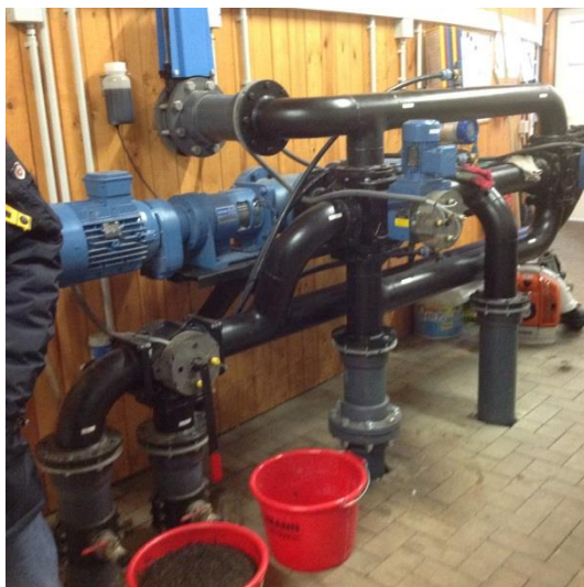
圖 26 沼液輸送泵(可輸送高濃度沼液)
