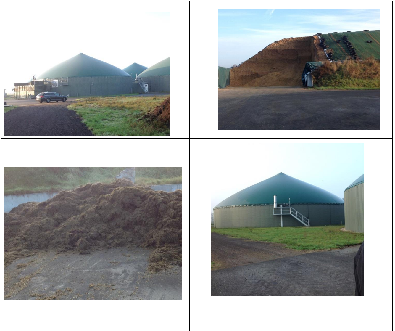
圖 13 沼氣廠外觀及能源作物堆放
