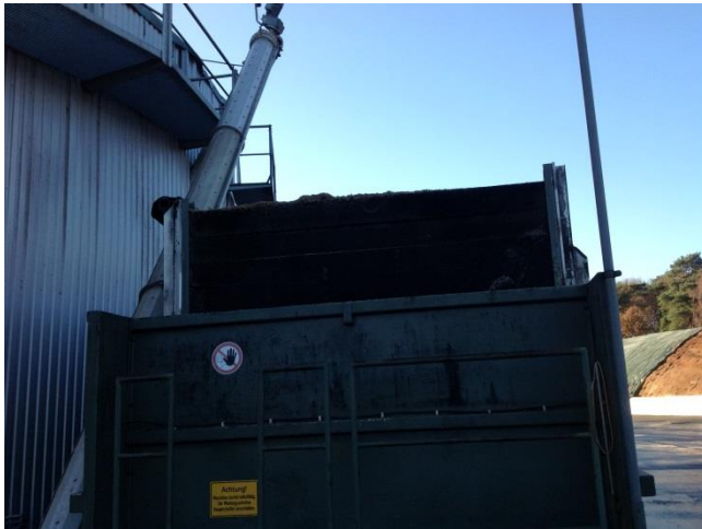
圖 12 輸送裝置可將物料由發酵槽上方投入
