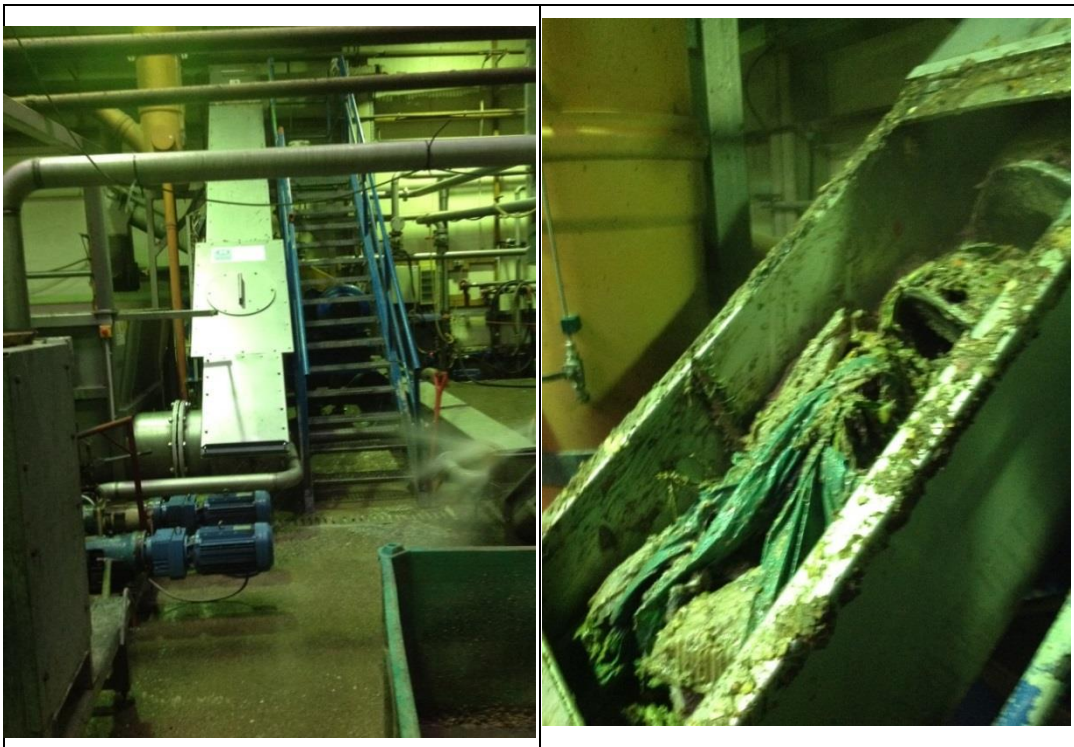
圖 19 垃圾破碎輸送裝置
