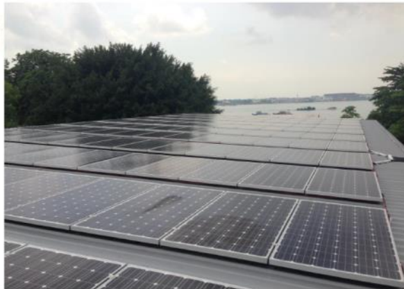
圖二十六、屋敏島上太陽光電的建設(2/3)
