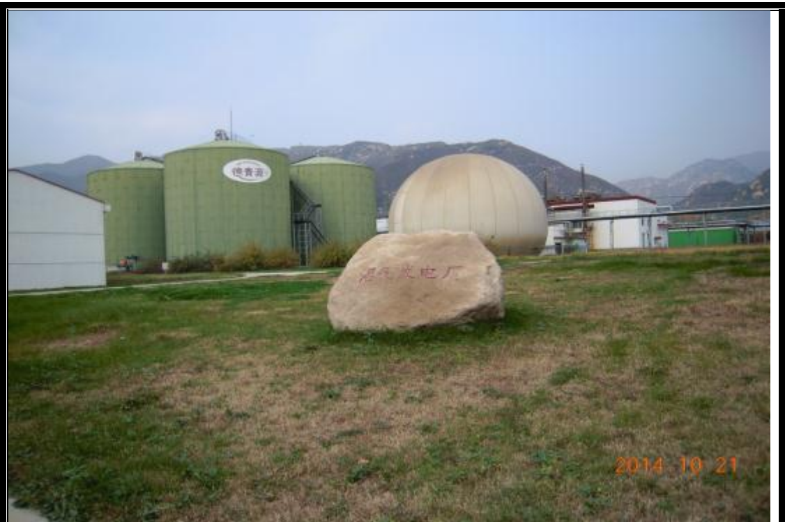
德青源生態園沼氣發電廠
