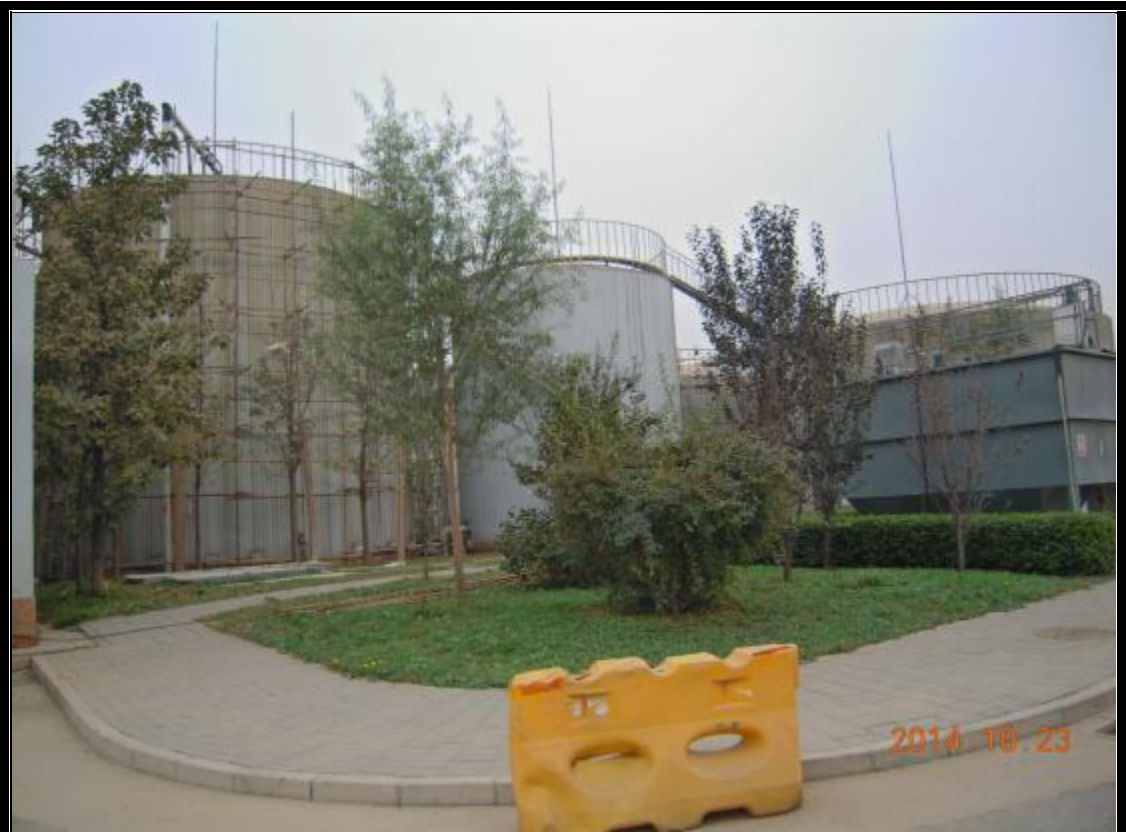
安定衛生掩埋場滲出水處理設施
