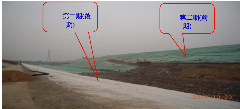
圖 3.2-24 安定衛生掩埋場第二期掩埋區
