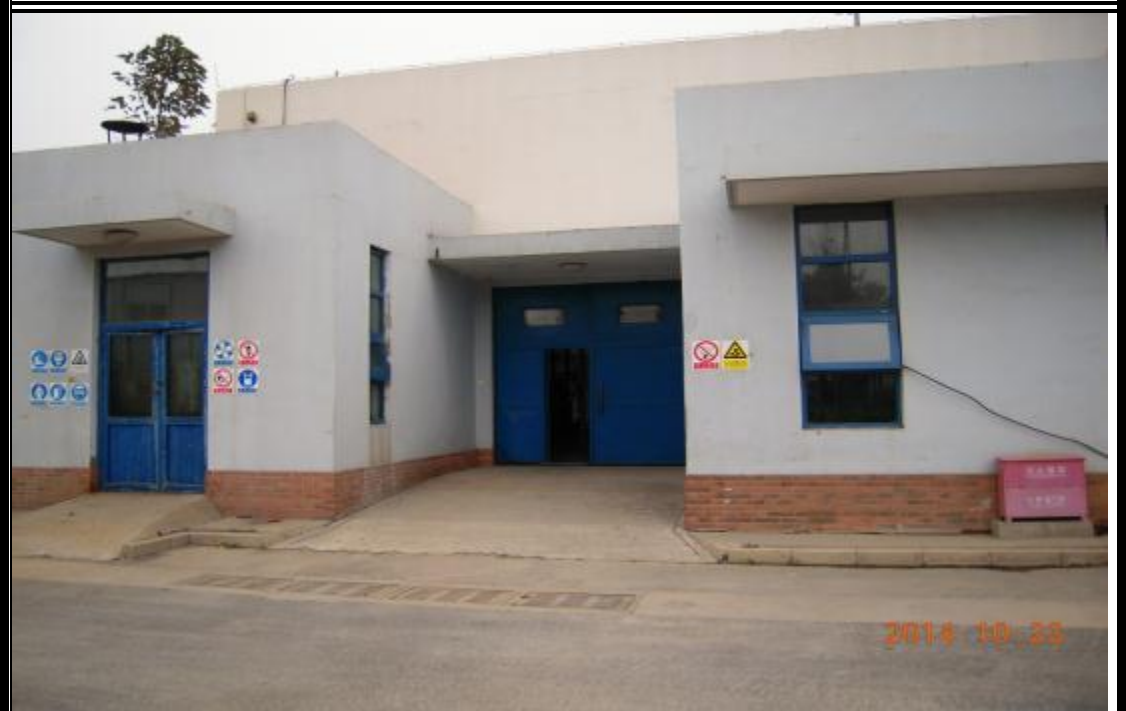
安定衛生掩埋場滲出水三級處理廠房
