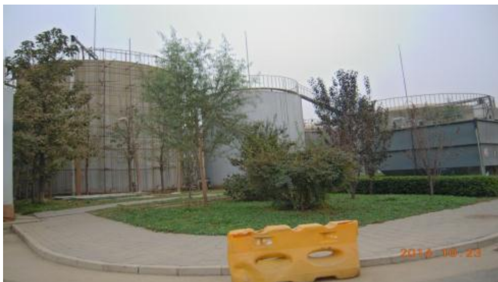
圖 3.2-27 安定衛生掩埋場垃圾滲出水處理廠
