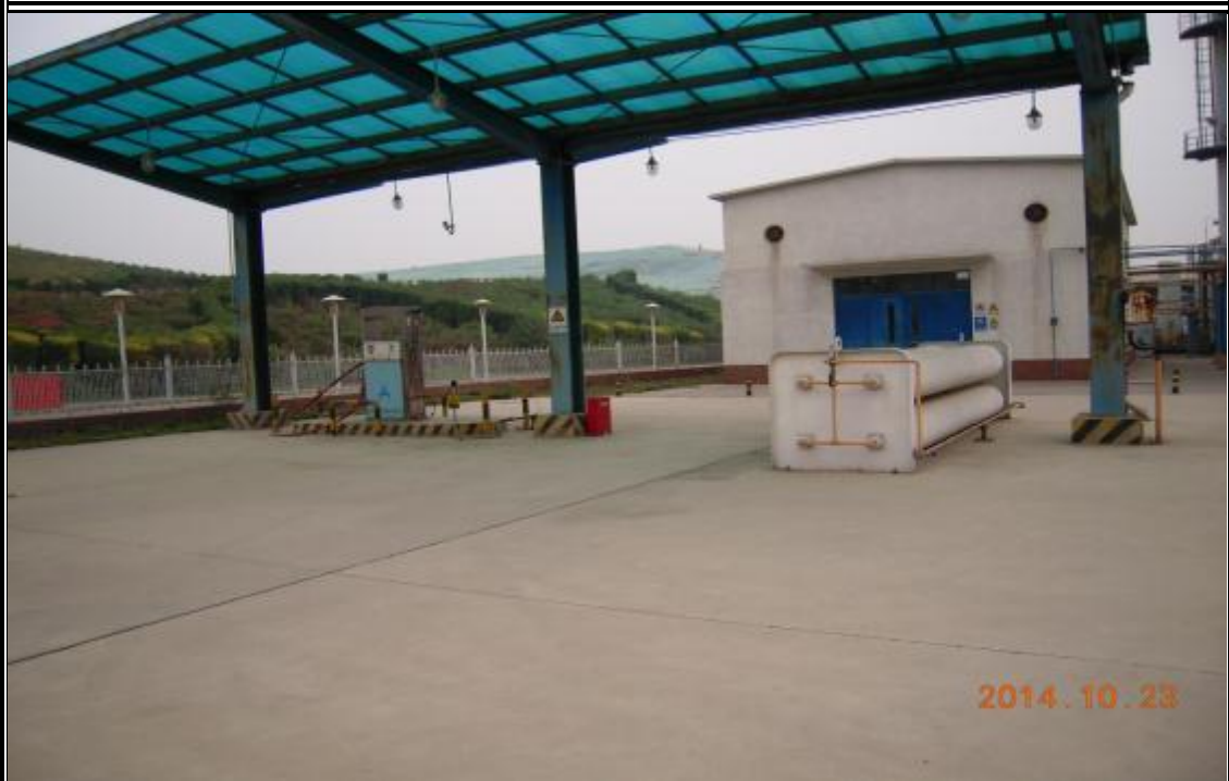
安定衛生掩埋場天然氣加氣站
