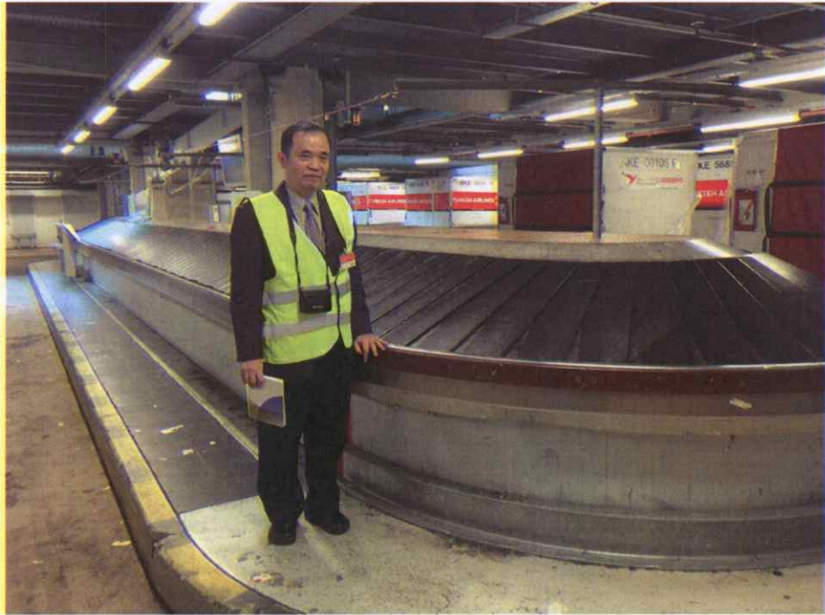
圖九：出境行李處理轉盤基座高度提高，減少地勤人員工作傷害
