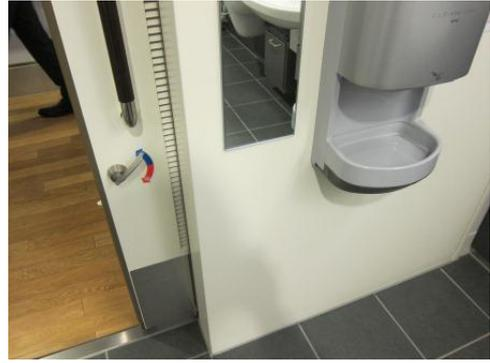
圖 85：乾洗手機與門片開關高度降低以符合使用者需求
