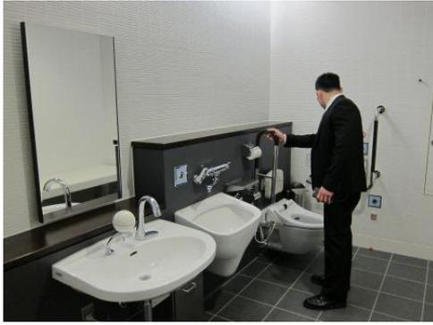
圖 84：無障礙洗手間，設施高度降低，並設置輔具
