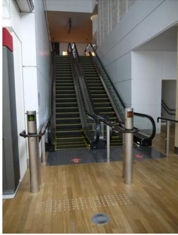
圖 80：踏板以 LED 燈號顯示行進方向，兩側方向燈柱亦提醒旅客
