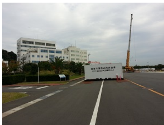
港灣汙染防止用具倉庫 防止港灣汙染相關設備儲存處
