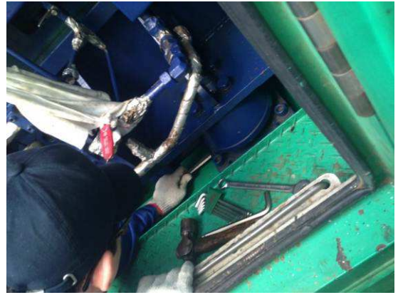
基礎螺栓檢查
