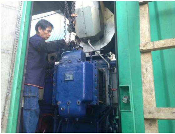
Air Cooler 吊出
