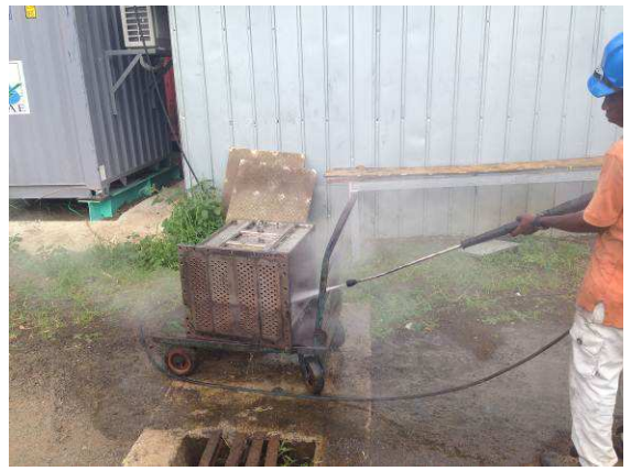
Air Cooler 清洗
