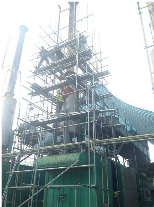
煙囪除銹前的搭架情形
