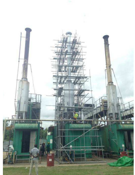
煙囪除銹上漆後
