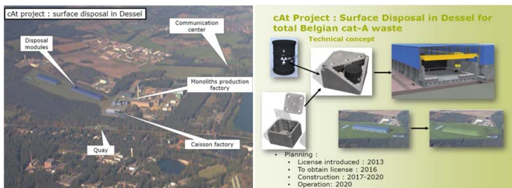
位於 Dessel 的地表最終處置場
