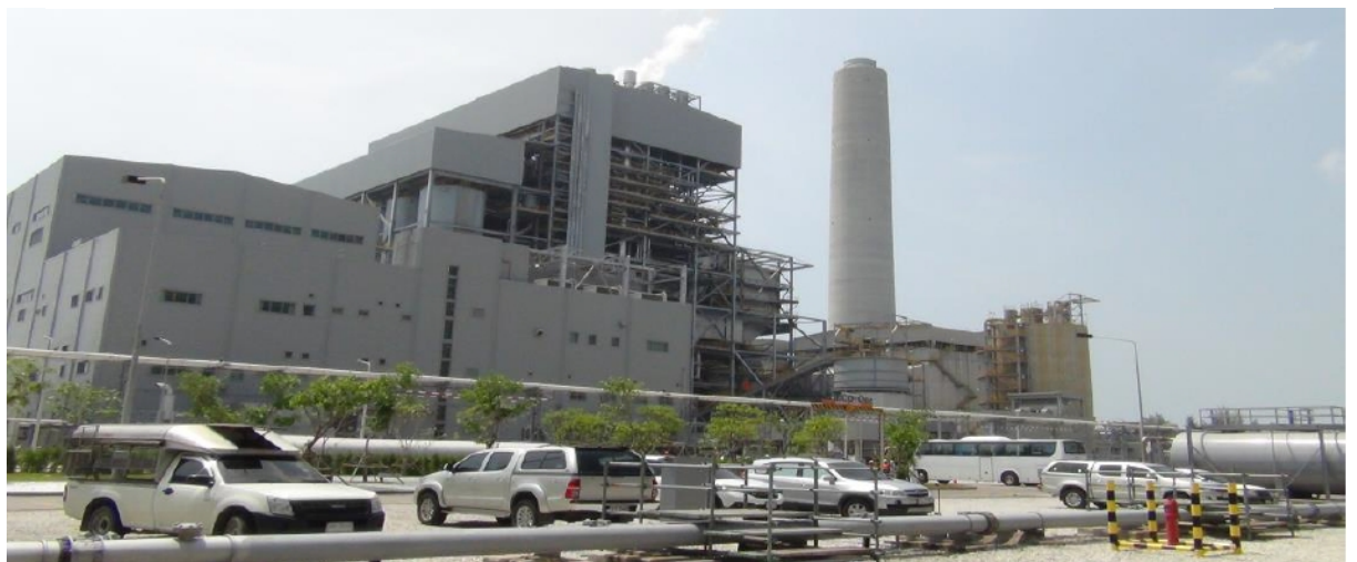
照片 1：Gheco-One 電廠超臨界鍋爐廠房及煙囪外觀
