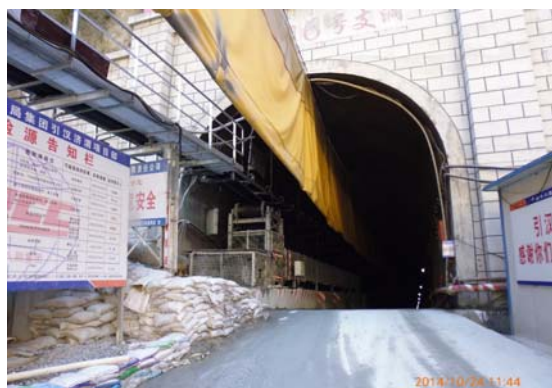
照片 11 秦嶺輸水隧道 6 號支洞
