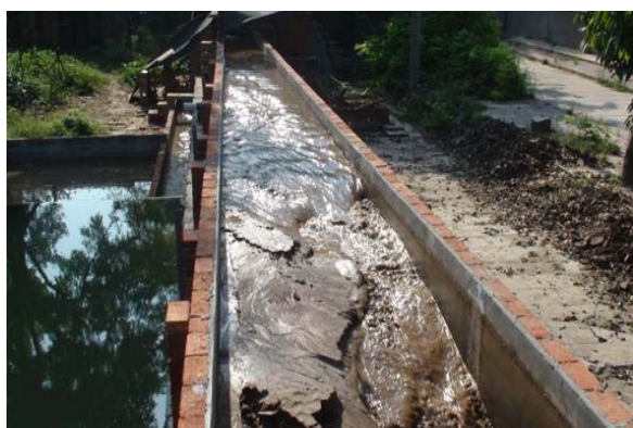
照片 18 泥砂试验渠道
