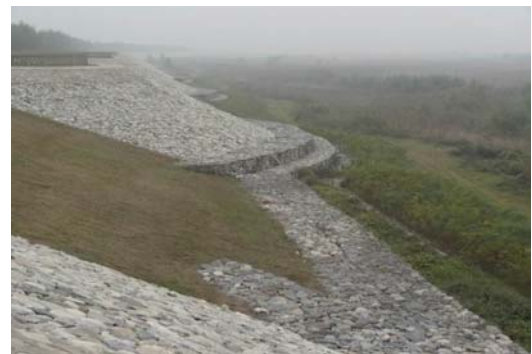
照片 10 草灘段之大堤防護岸
