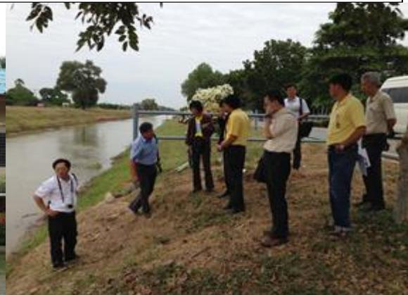
Krasiew 灌溉計畫區右側主幹灌渠，無內面工，流速緩慢，輸水損失大。
