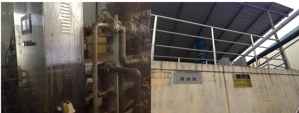
圖 11 吳淞江污水廠污泥調質機（左圖為舊型，右圖為新型）
