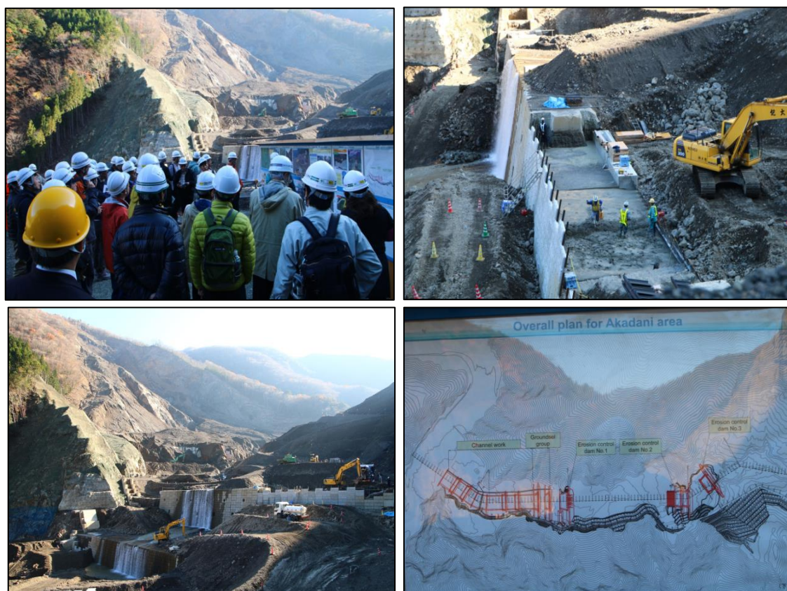
圖 42 Akadani 地區現場參訪施工情形
