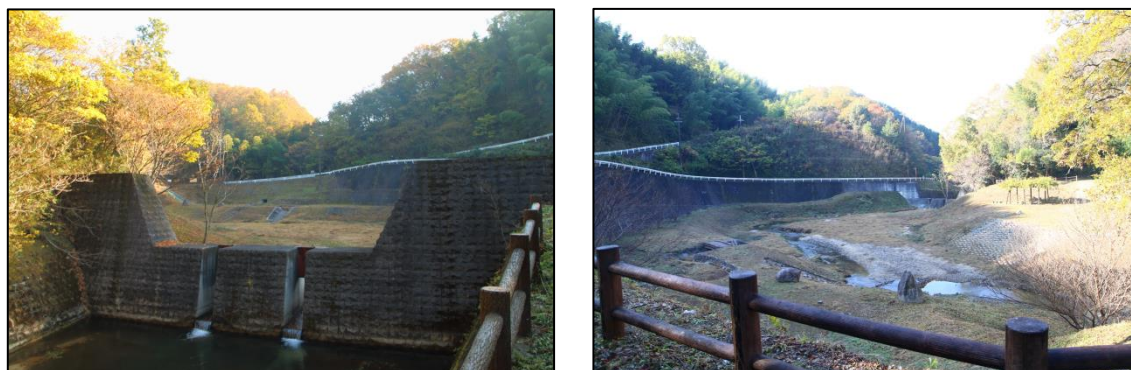
圖 6 不動川近代施設之防砂壩仍維持空庫情形
