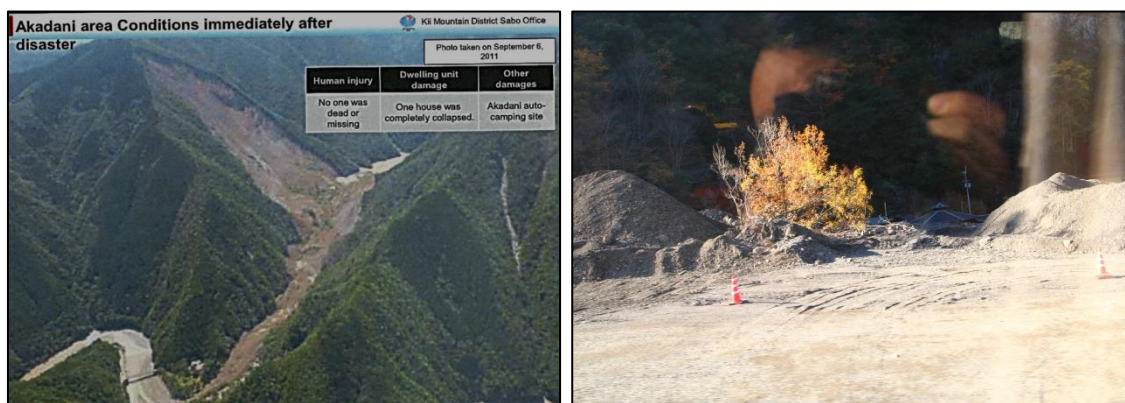
圖 41 Akadani 地區 2011 年發生深層崩塌及災害情形
