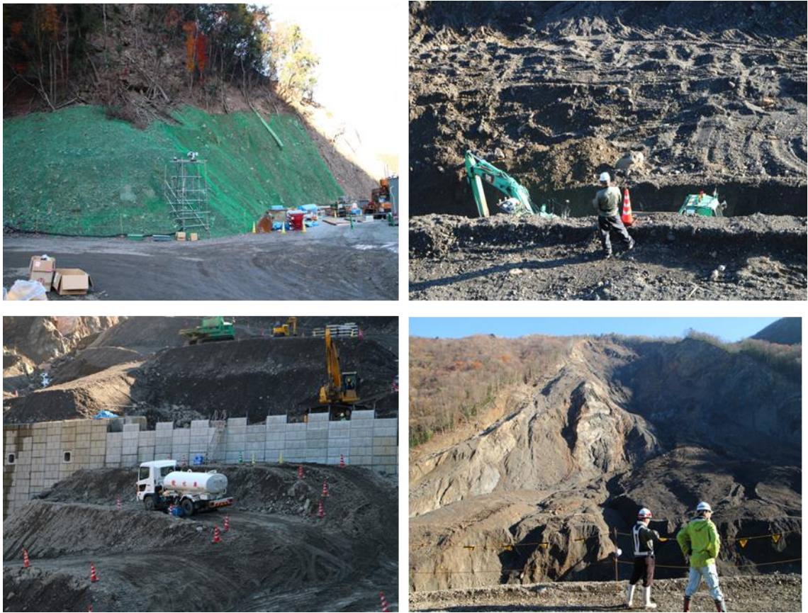
圖 43 Akadani 地區現場參訪施工情形
