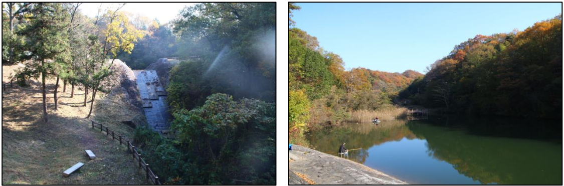
圖 4 不動川防砂壩兼具貯砂及蓄水功能
