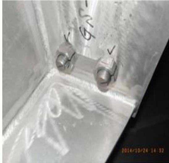
所有固定螺栓均有LOCKING PLATE或利用電焊固定
