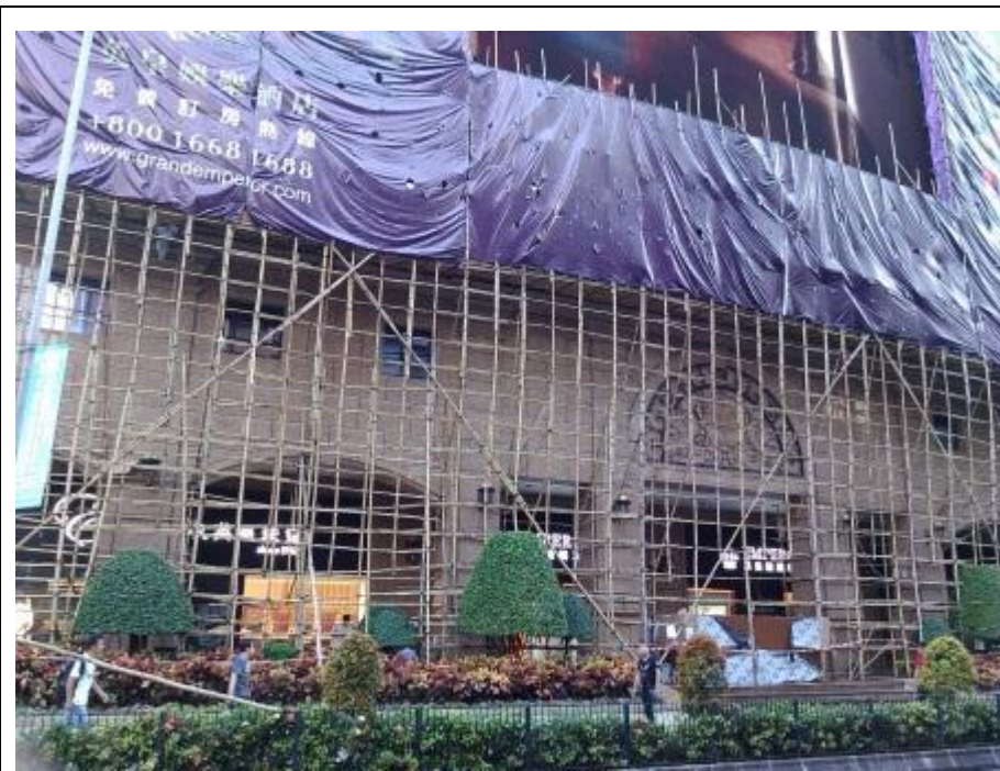
圖 22 澳門市區於從事搭設(竹製)棚架從事大樓維修作業 2
