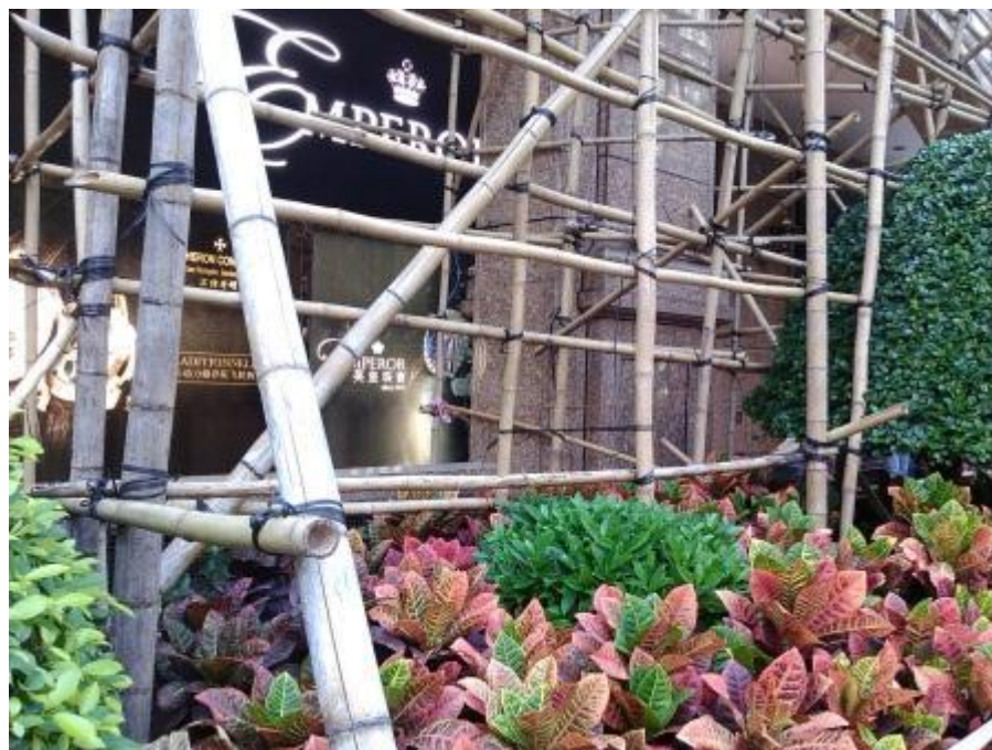
圖 23 澳門市區於從事搭設(竹製)棚架從事大樓維修作業 3
