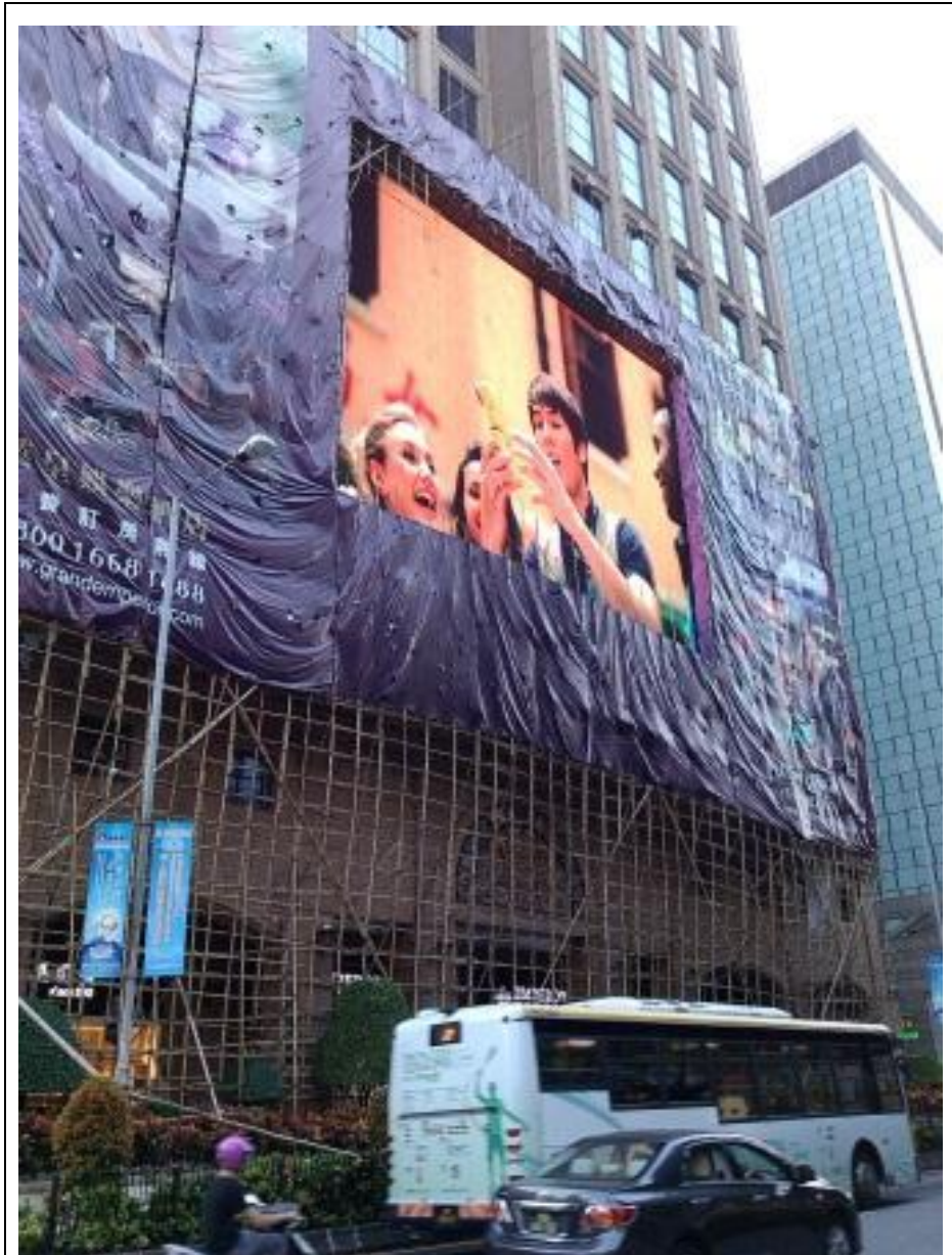
圖 21 澳門市區於從事搭設(竹製)棚架從事大樓維修作業 1
