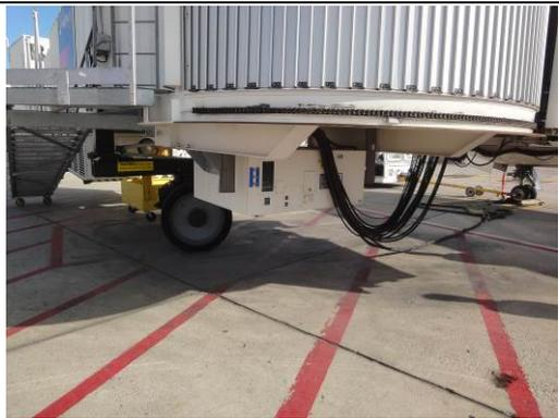
400Hz 飛機供電設備懸掛及多線式電纜
