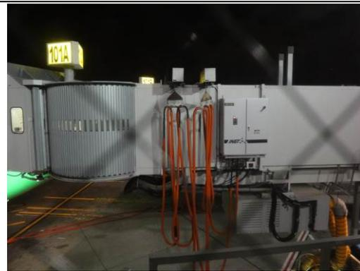
橋電設備電纜採彈簧吊掛方式
