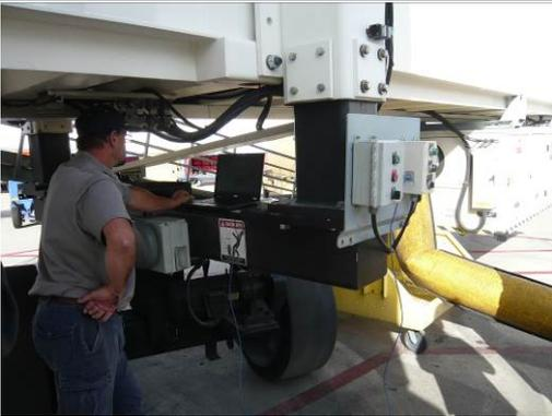
筆電連接 PCAIR 操作箱監視設備運轉狀態
