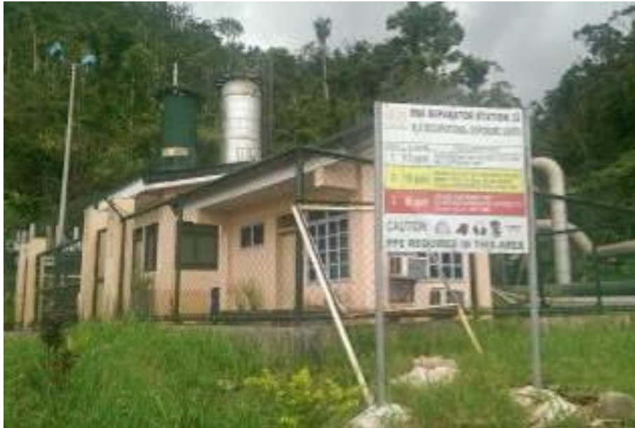
圖 14 Leyte地熱電廠區之H 2 S監測站與H 2 S分離系統(scruber)
