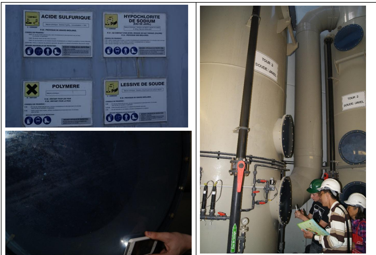
貯存藥品桶槽及物料觀景窗(藥品：硫酸(左上)、高分子凝聚劑(左下)、次氯酸鈉(右上)、氫氧化鈉(右下))
