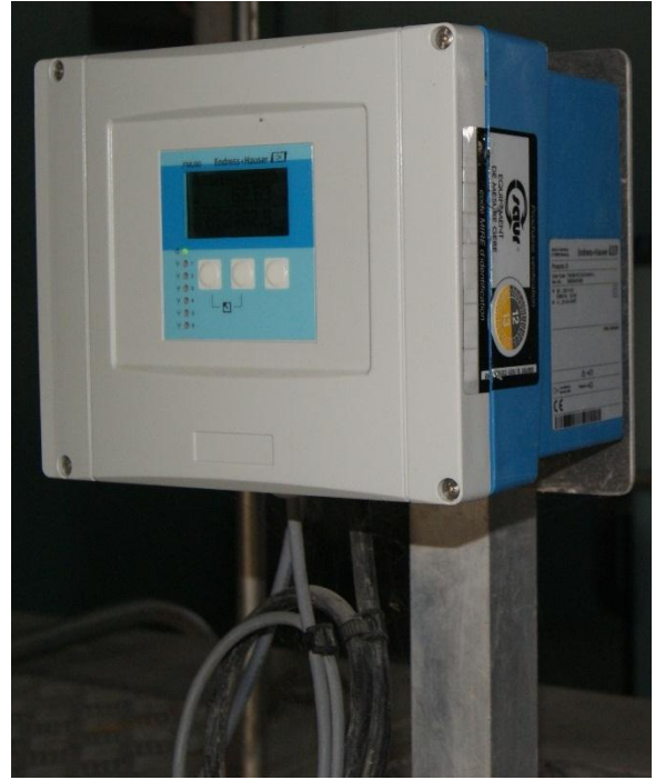
超音波液位計可記錄液面高度及累計流量
