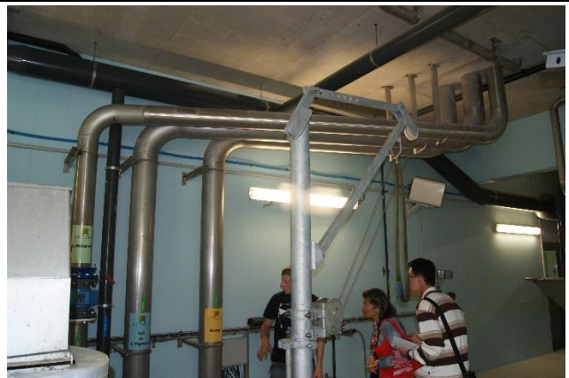
抽水幫浦提高廢水揚程將廢水抽至高處再以重力流方式依序處理以節省能源
