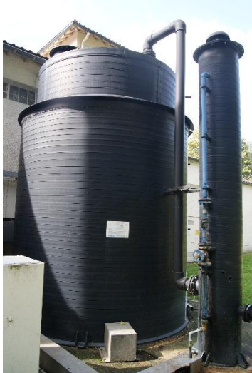
鹽酸加藥設備及貯存藥品桶槽(雙層防溢防洩設施)，該場利用鹽酸調整 pH 值
