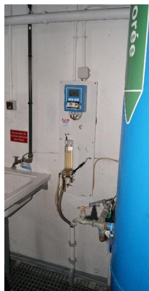
餘氯線上監測儀(加氯控制在 0.6~0.8 mg/L)
