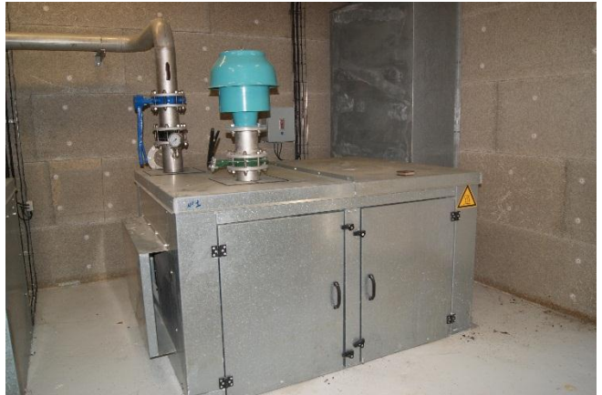
鼓風機抗震減噪隔音設備
