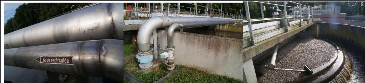
污泥迴流管回流至污泥濃縮池刮除表面浮渣
