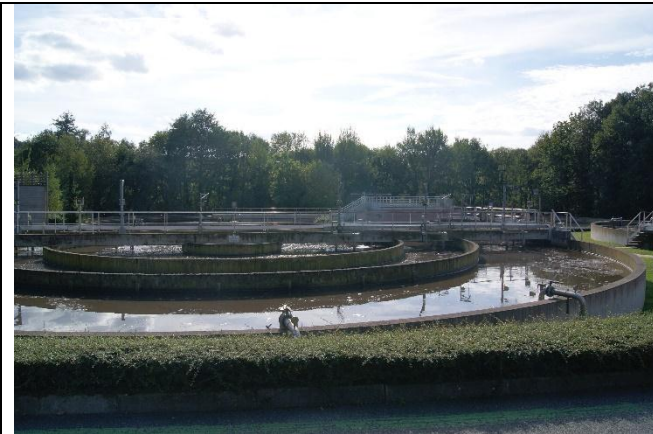
生物活性污泥曝氣池
