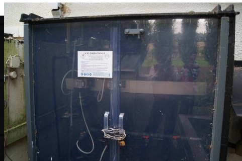
鹽酸加藥設備及貯存藥品桶槽(雙層防溢防洩設施)，該場利用鹽酸調整 pH 值
