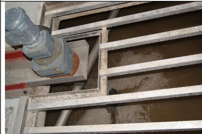
氣曝浮除沉砂刮脂設備
