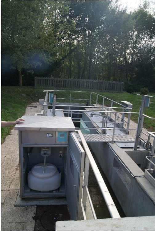
放流渠道及放流水水樣自動採樣設備
