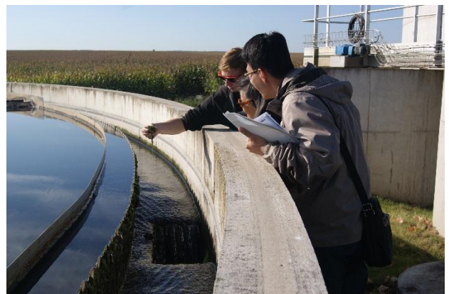
經沉澱後之放流水(加氯消毒後即可放流)
