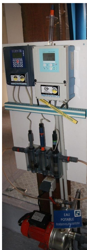
清水池水質線上監測儀器 (持續監測項目：pH 值、溫度、餘氯)
