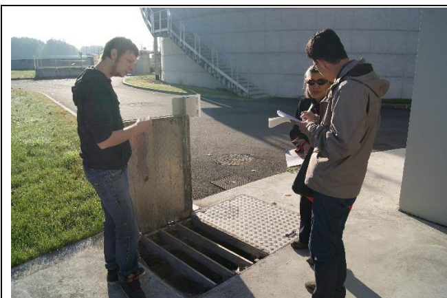
雨水收集井可逕流排放或當緩衝調節用
