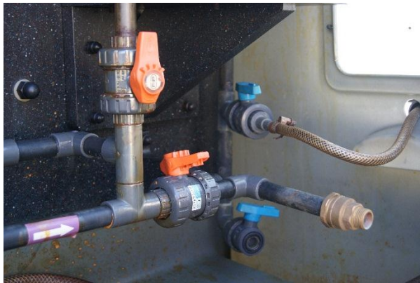
氯化鐵加藥管線接頭
