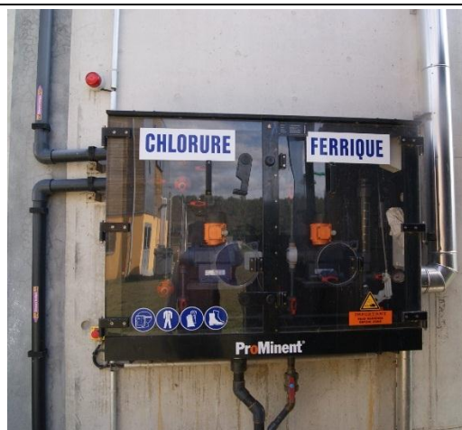
加藥設備(左：液氯；右：氯化鐵)
