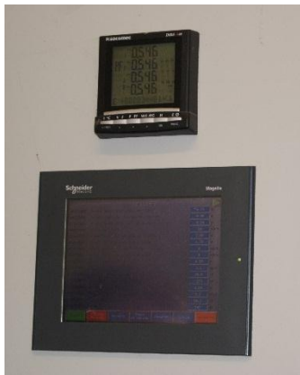
中控介面(可顯示並可調整多項水質參數)
