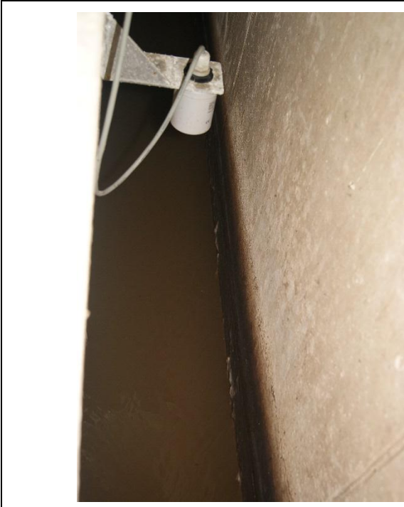
超音波液位計可記錄液面高度及累計流量
