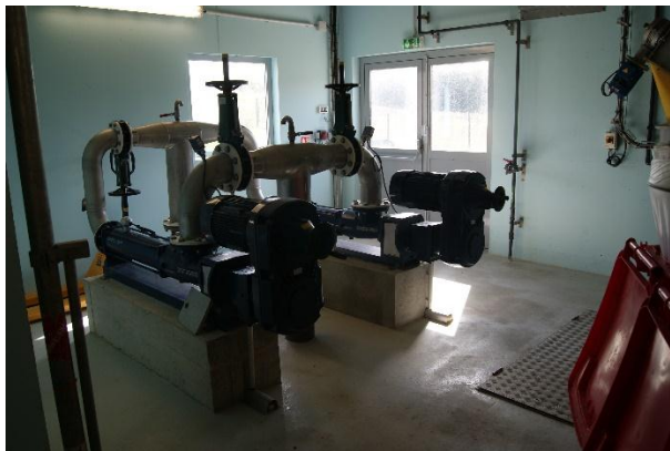
抽水幫浦提高廢水揚程將廢水抽至高處再以重力流方式依序處理以節省能源
