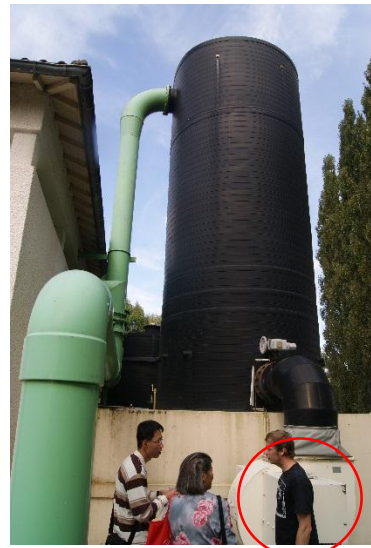
抽水提高揚程至蓄水桶槽並曝氣，密閉避光避免藻類滋生。紅色部分：鼓風機
