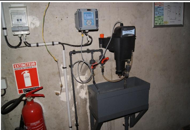
沉澱水線上監測濁度計
