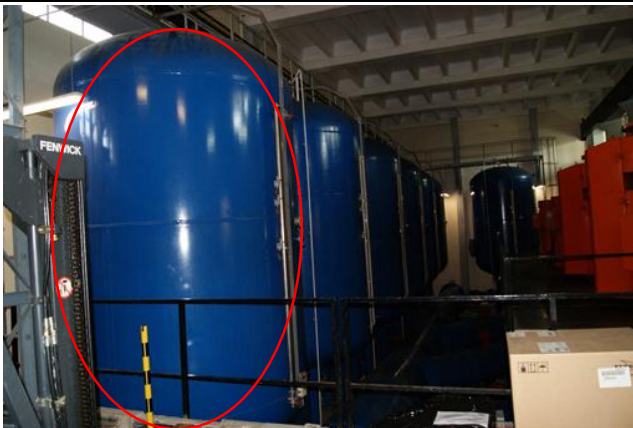
六台大型配水幫浦分別將處理後之清水分送各 11 萬 CMD 至巴黎左、右岸，管徑 1.2m，管壓 11bar，其六座藍色大型鋼桶槽為避免因突發事故導致幫浦重啟所引發之水錘現象設施
