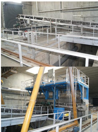
進流廢水攔污固液分離篩分機
