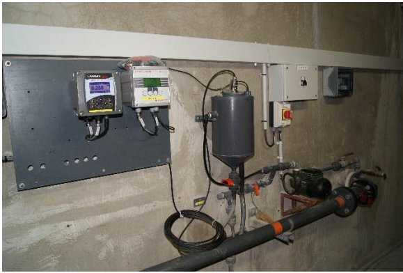
清水線上水質監測儀器
