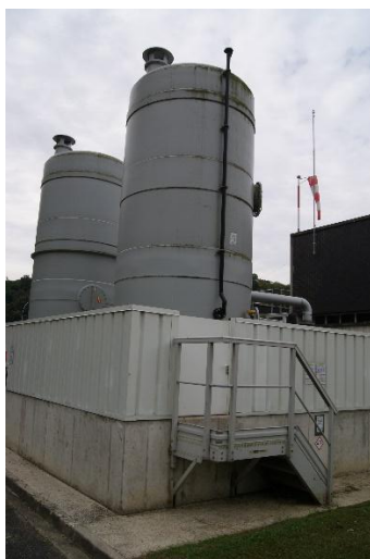
避免因液氯外洩遭受污染之清水暫存槽收集裝置，通常使用硫代硫酸鈉中和去除過多的氯
