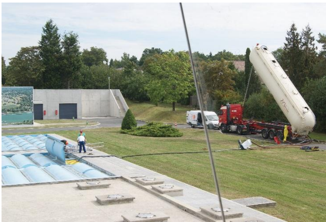
活性炭槽車卸料情形
