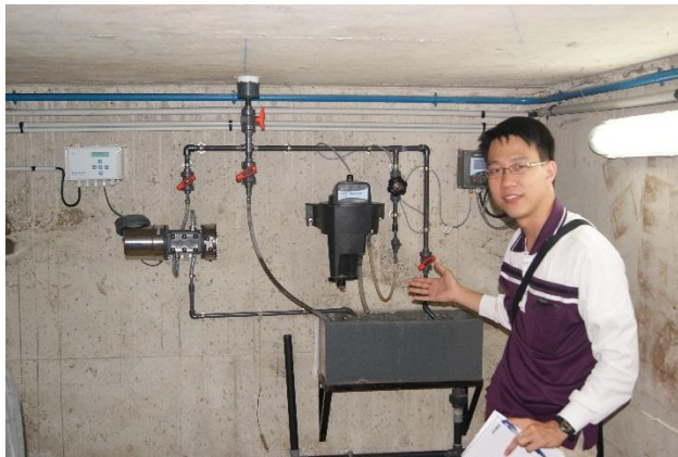
沉澱水線上監測濁度計
