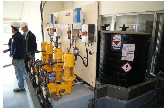
混凝劑加藥系統(混凝劑：硫酸鋁)
