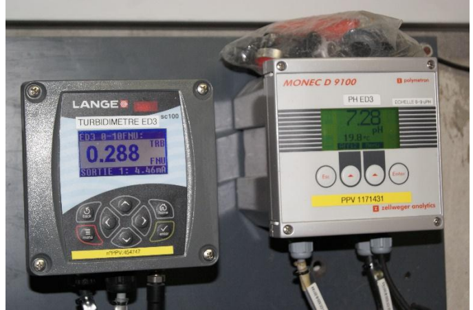
清水線上監測水質項目(濁度、pH 值)
