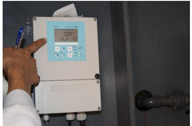
原水線上監測 pH、水溫計
