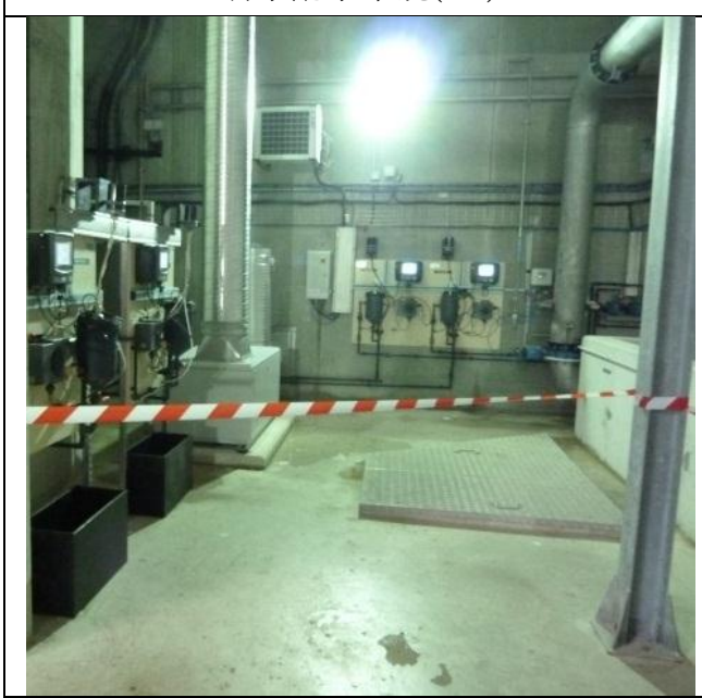
線上水質監測儀器
