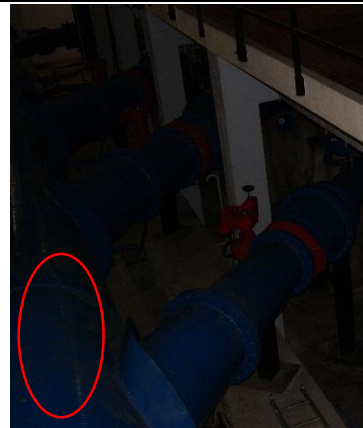
六台大型配水幫浦分別將處理後之清水分送各 11 萬 CMD 至巴黎左、右岸，管徑 1.2m，管壓 11bar，其六座藍色大型鋼桶槽為避免因突發事故導致幫浦重啟所引發之水錘現象設施
