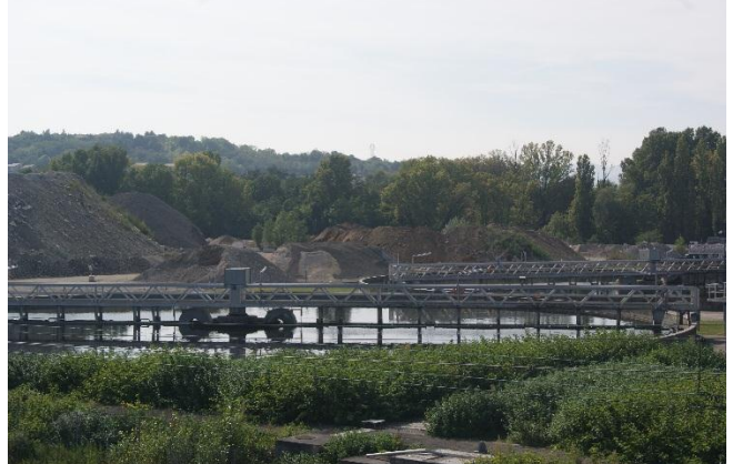
脫水污泥堆置場
