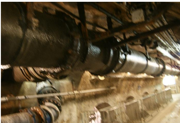
污水下水道中雨水收集管線
