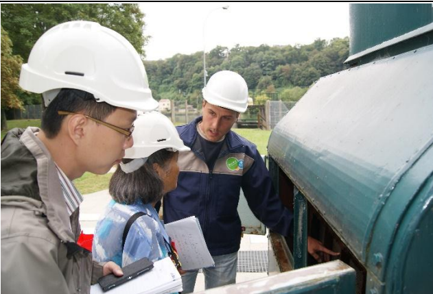
細攔污柵去除雜物
