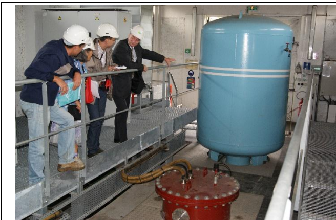
藍色桶槽為保護管線與抽水機裝置，避免因突發事故導致原水抽水機重啟所引發之水錘現象
