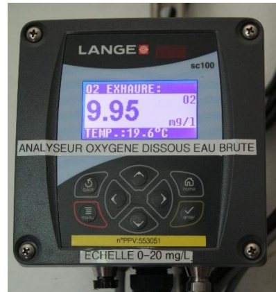
溶氧水溫線上即時監測儀 (單位：O 2 mg/L)
