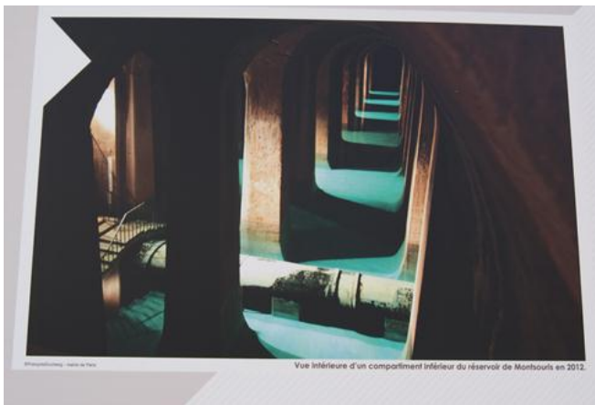
地下蓄水池(庫)蓄水實景(翻拍海報)
