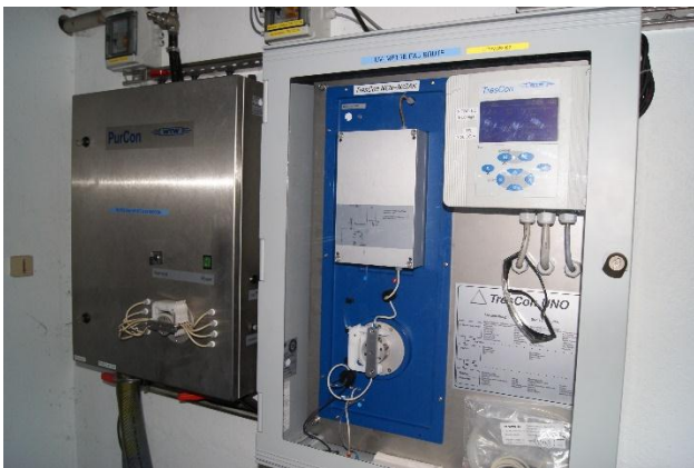
原水線上水質監測儀器 (檢測項目：NOx、Do、temperature、CHx)
