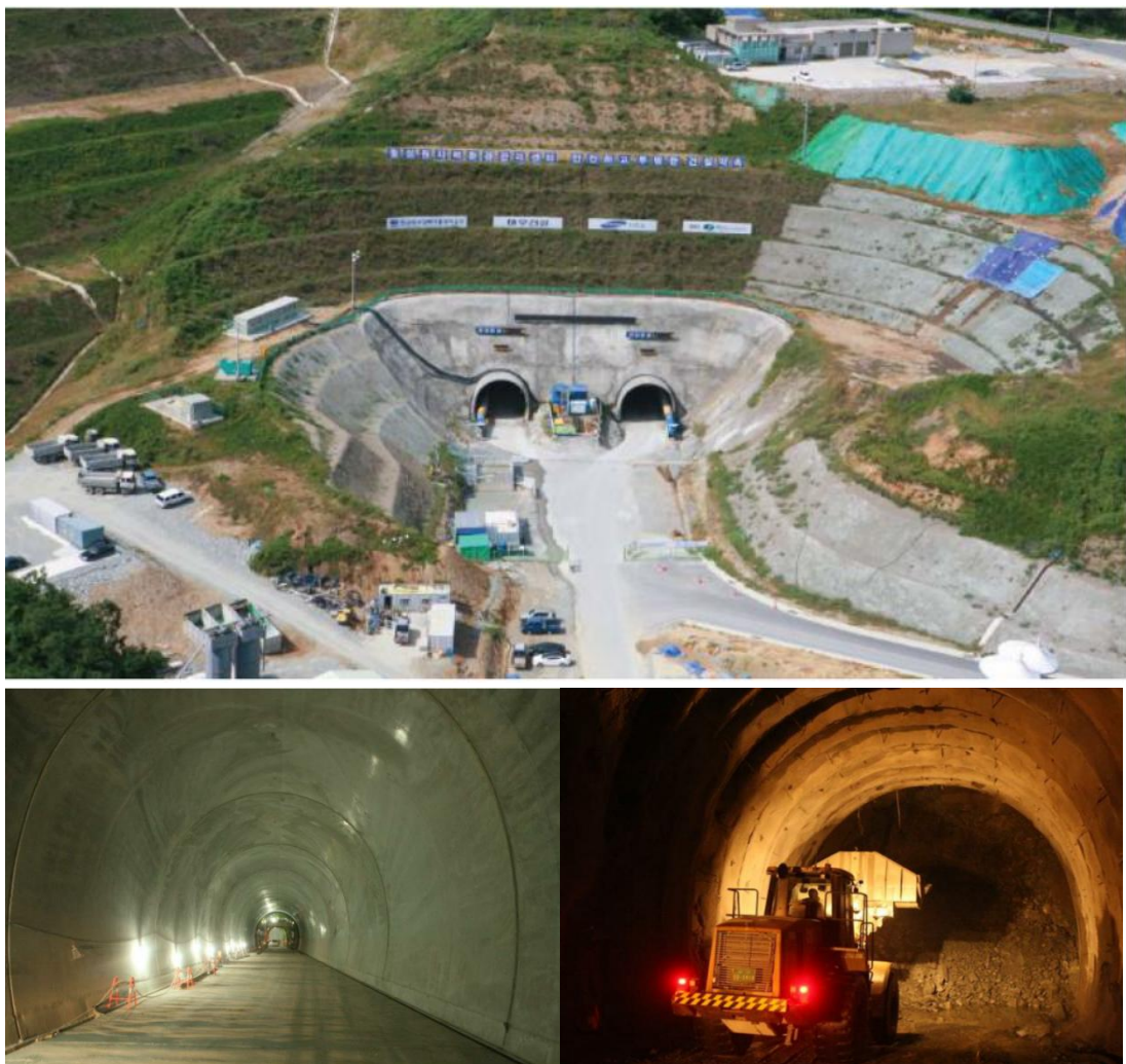
圖十九、中低放射性廢棄物處置場隧道挖掘
