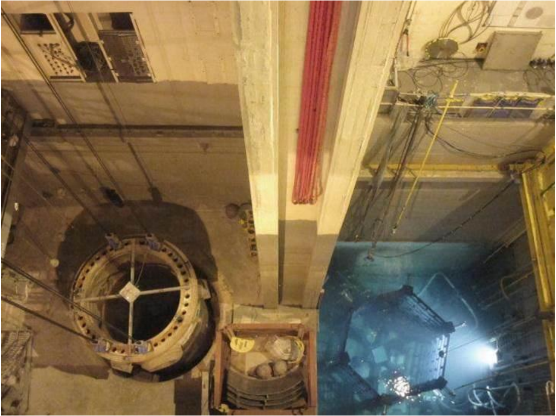
圖五、西班牙 JOSÉ CABRERA 核能電廠 RPV 切割拆解(二)
