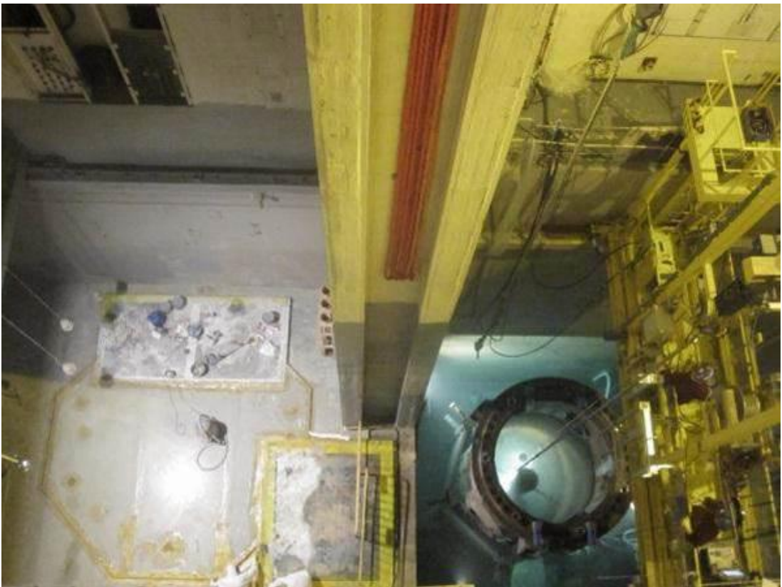
圖六、西班牙 JOSÉ CABRERA 核能電廠 RPV 切割拆解(三)
