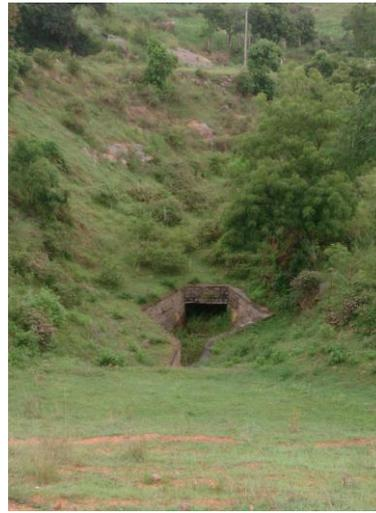
圖 33 左側下游溢流排水系統
