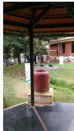
圖 18 建築物旁集水池(左圖)、涼亭集水筒(一)(中圖)、涼亭集水筒(二)(右圖)
