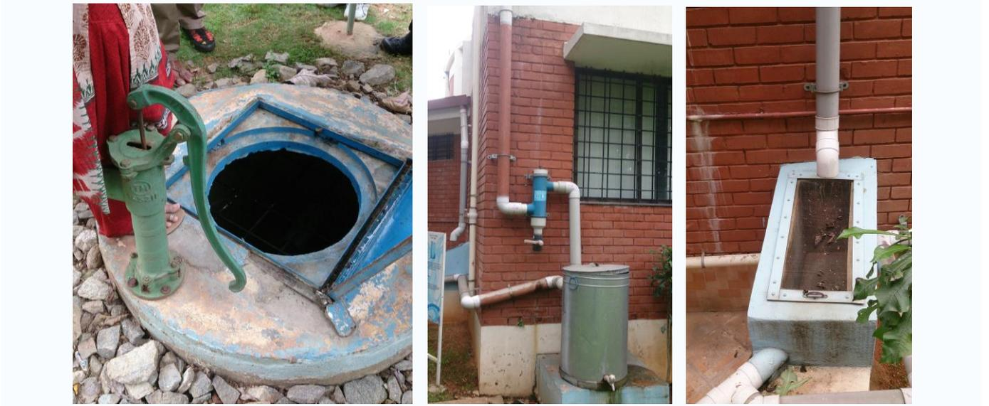
圖 19 集水井(二)(左圖)、簡易集水筒(中圖)、濾網與彙流池(右圖)
