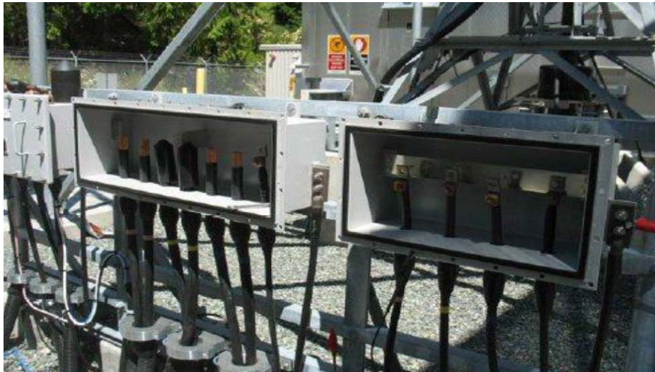
圖 36 接地電纜之電流傳感器示意圖
