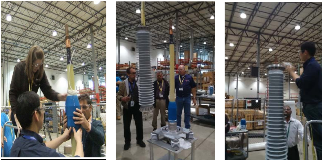
圖 32 終端匣施工之相關照片
