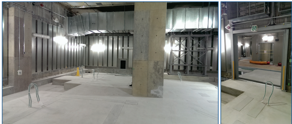
圖十七 牛島町變電所施工環境
