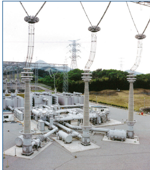
圖十三 1100 kV 變壓器及開關設備
