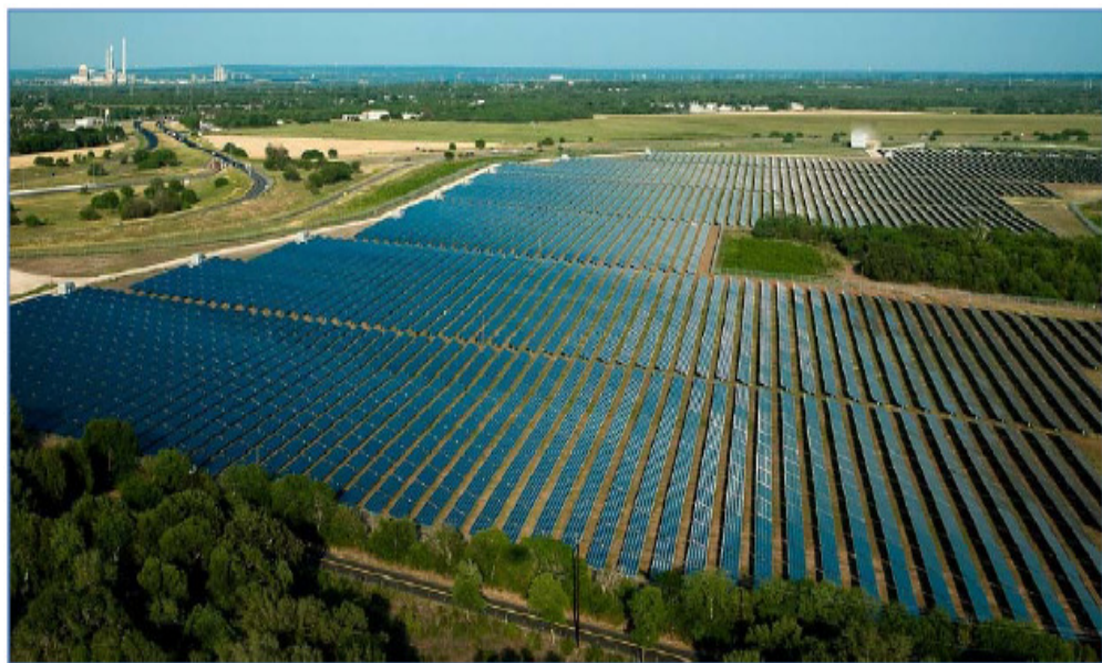
圖 40 Blue Wing PV 太陽光電場域的空照圖
