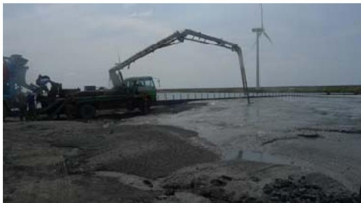
圖二、為防止水面下澆置造成材料析離之特密管施工過程
