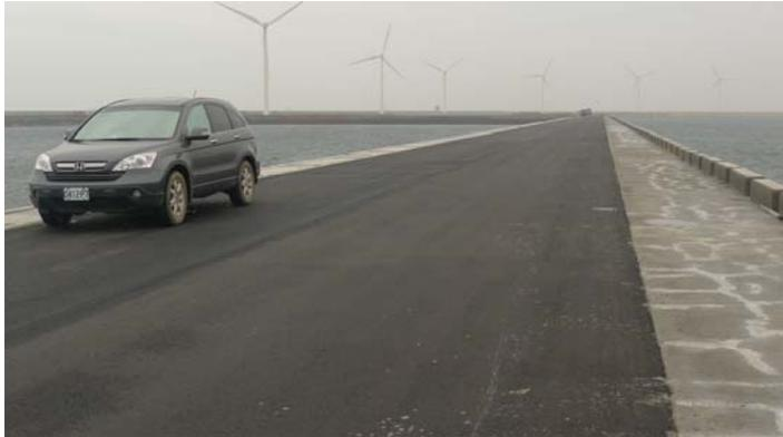
圖三、完成之煤灰 CLSM 隔堤道路
