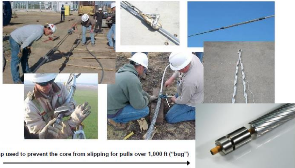
圖 5 ACSS 延緊線施工使用工具
