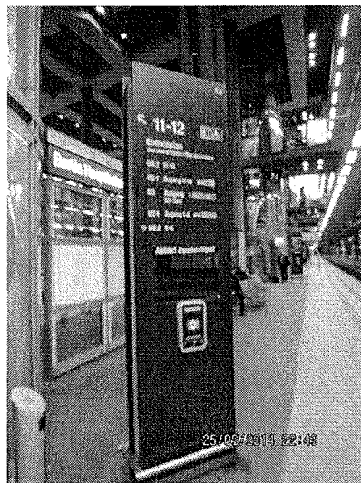
圖 71 柏林中央車站月台資訊看板及緊急呼叫按鈕
