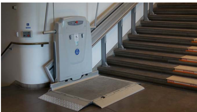
無障礙設施，輪椅專用電動梯，使用後平台可以靠牆收折起來
