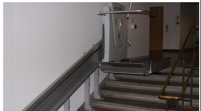
無障礙設施，輪椅專用電動梯，使用後平台可以靠牆收折起來
