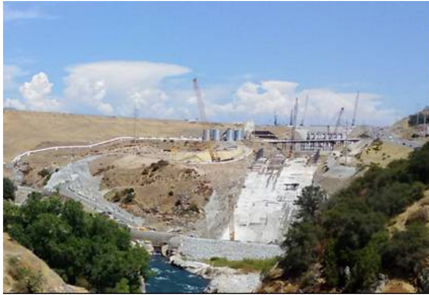
圖 8、佛森水庫輔助溢洪道施工現況(往上游側)
