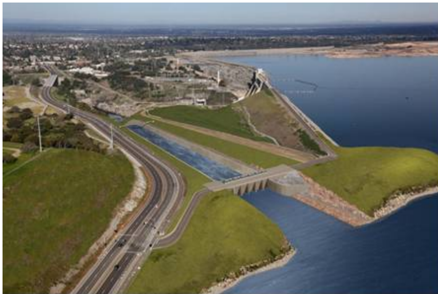
圖 9、佛森水庫輔助溢洪道完工示意圖(往下游側)
