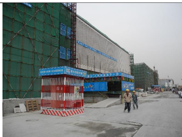
天橋演藝中心施工概況
