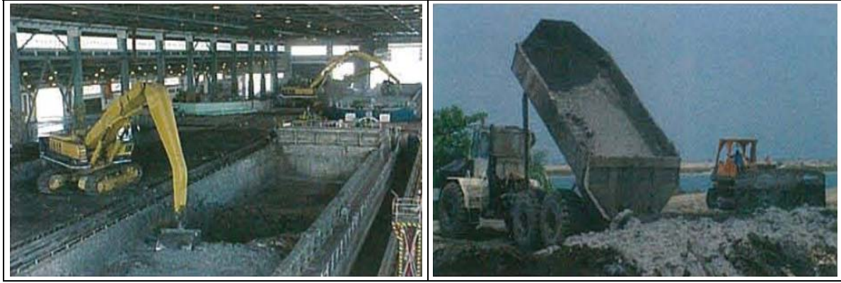
圖 41 實馬高島上之卸料與掩埋作業照片(圖片來源：國家環境保護署 (NEA) 提供)
