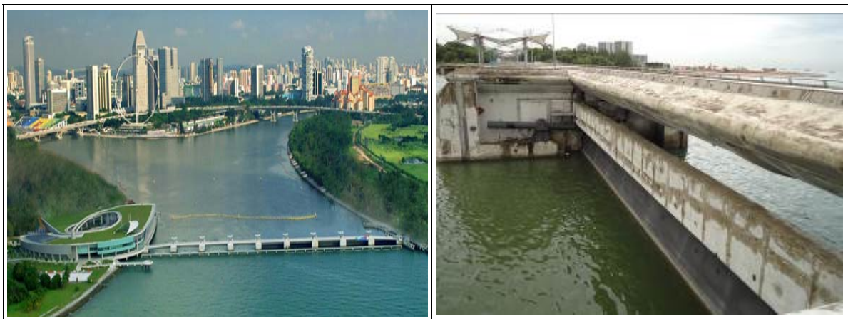
圖 45 濱海堤壩鳥瞰圖及活動壩體(兩側水色及水位不同)(左圖：公用事業局(PUB)提供)
