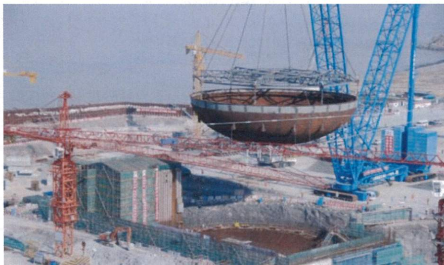
三門核電廠圍阻體底部模組吊運
