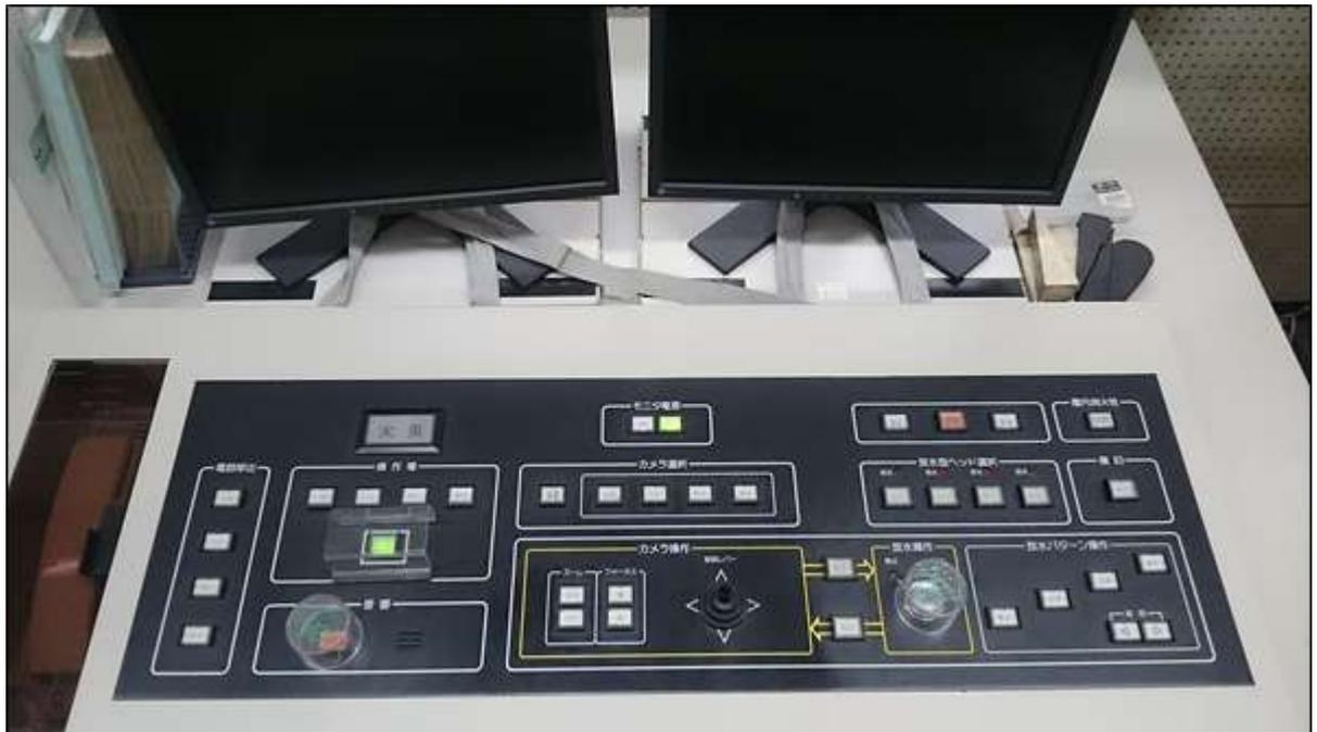
圖 9 成田國際機場系統監控中心火警控制面板
