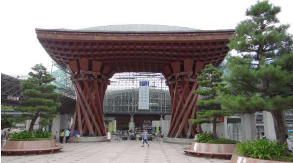
圖32 傳統の木造鐘樓與後端現代化鋼骨結構高架化站體完美結合成金澤站
