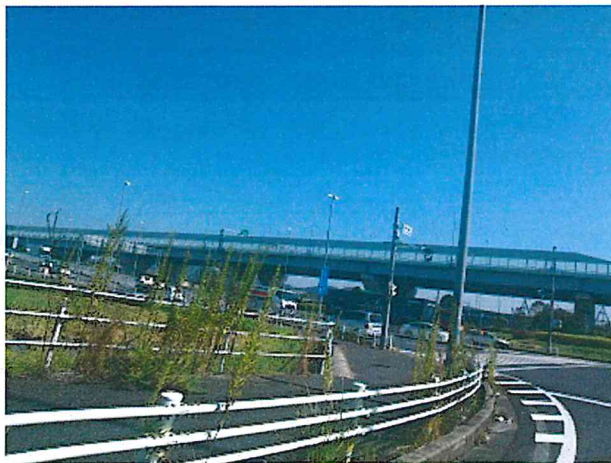
高架道路隔音牆外觀
